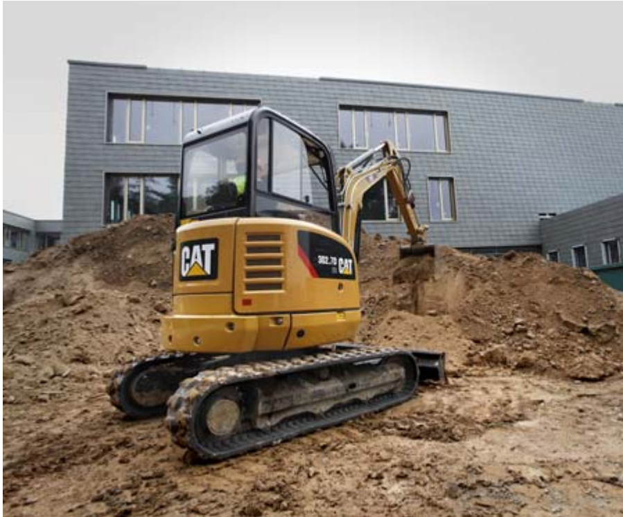
Imagen 3: Retroexcavadora de 3 toneladas realizando la excavación para la construcción de una piscina.
