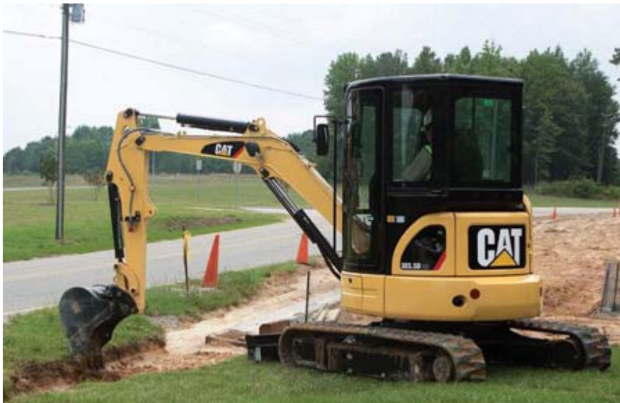
Imagen 2: Retroexcavadora de 4 toneladas construyendo zanja en un camino rural.
