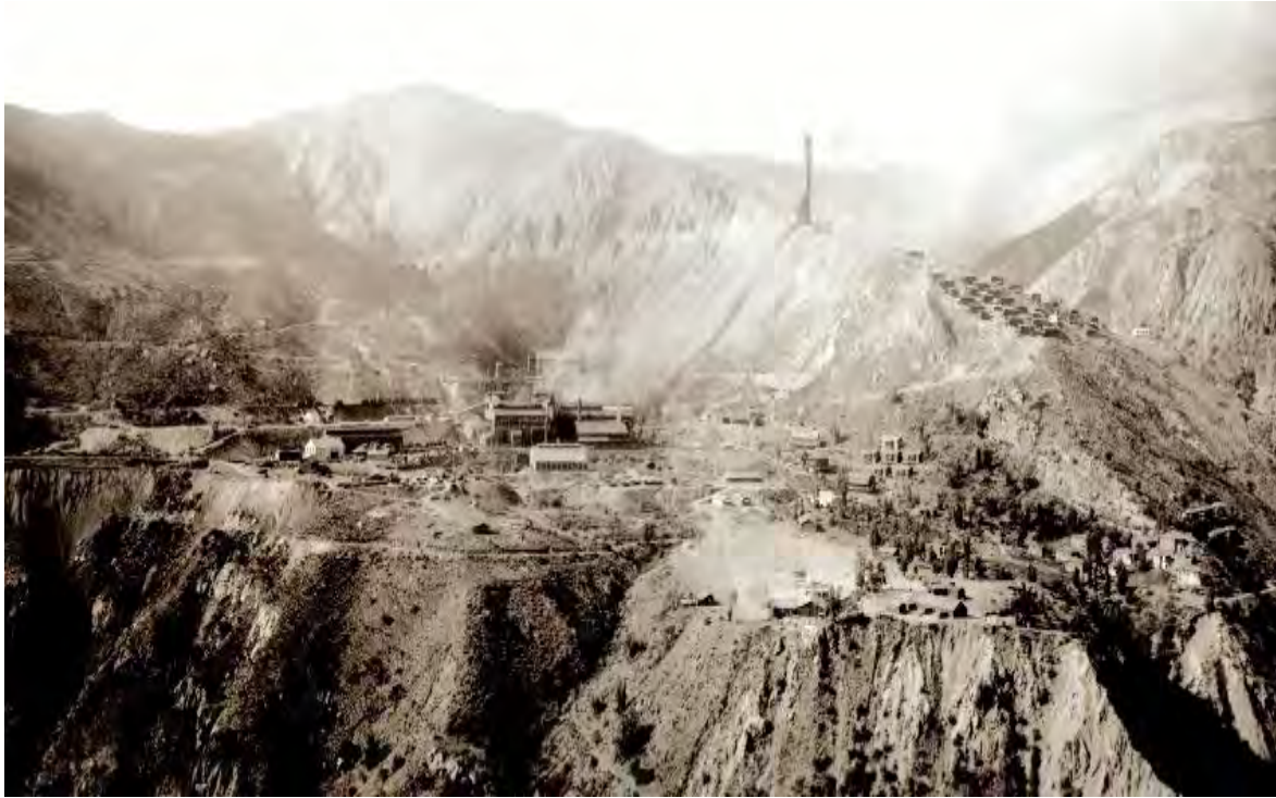
Fotografía N°6: Vista general del Campamento de Caletones, s/f.
