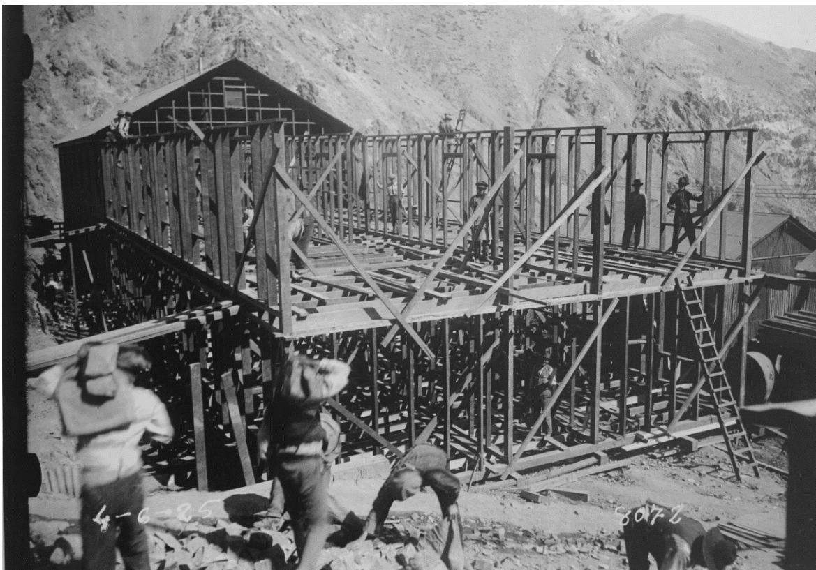
Fotografía N°10. Construcción de camarote, Sewell 1925.
