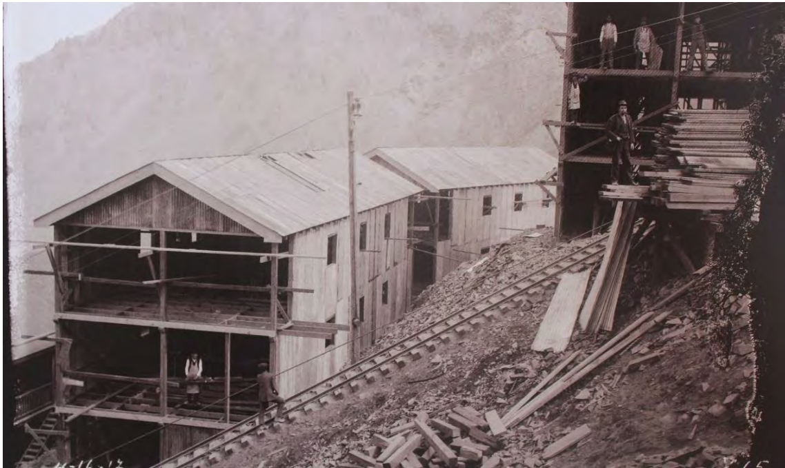
Fotografía N°11: Construcción de camarotes con Calamina. Sewell, 1924.
