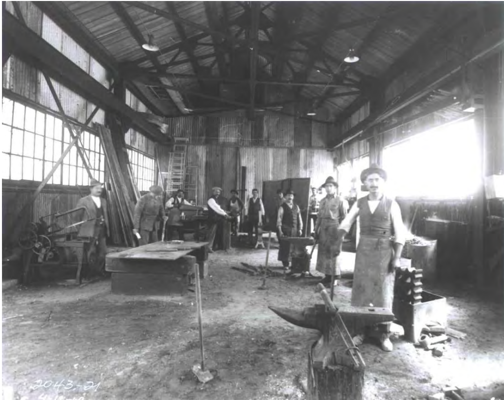
Fotografía N°4: Obreros en las calderas, s/f.
