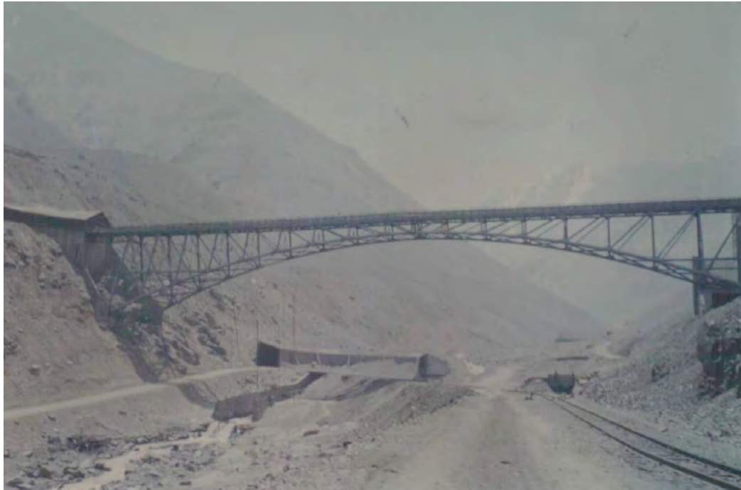
Fotografía N°18: Puente Rebolledo. Sewell, s/f.
