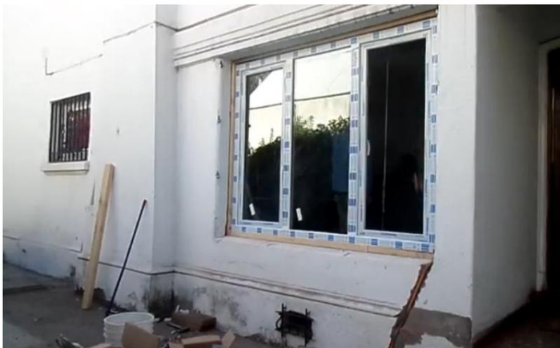
*Figura 6.2 Instalación de ventanas DVH*
