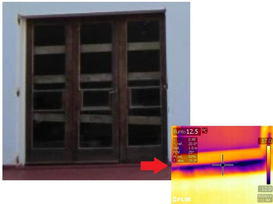
Figura 3.12 Infiltración a través de marco de ventana II
