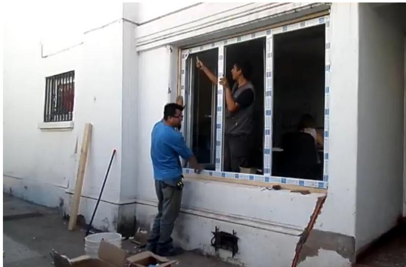
*Figura 6.1 Instalación de ventanas DVH*
