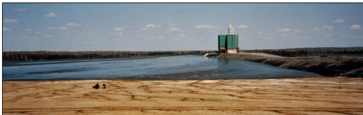
Figura 5: Depósito TTD, Kidd Creek, Canadá (3-4 % de pendiente).
