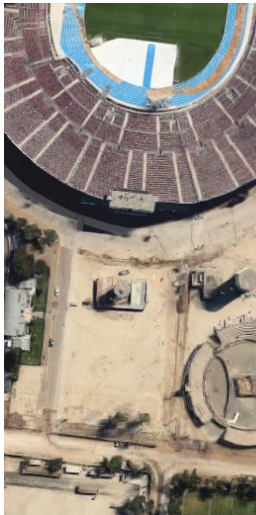
Imagen 6. Lugar donde se instalan las filas de ingreso para el Sector Galería Sur
