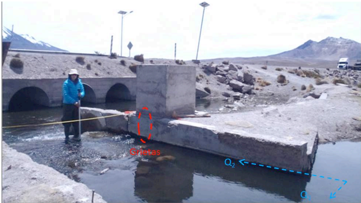
Figura 11-10. Estación fluviométrica "Río Chungará en desembocadura". Fuente: elaboración propia.
