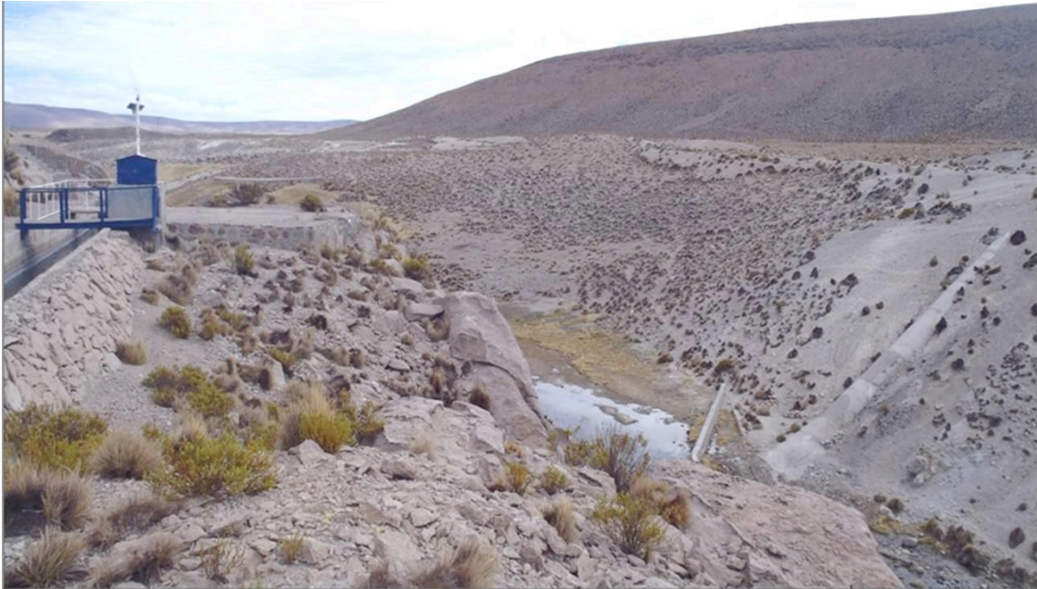
Figura 11-7. Estación fluviométrica "Río Lauca en Sifón Nº 1", Km 3,3 de la bocatoma del canal Lauca. Fuente: elaboración propia.
