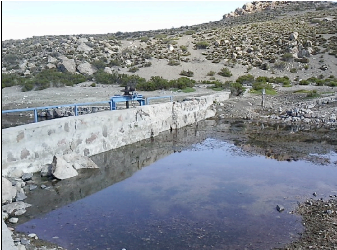
Figura 11-29. Obras de entrega "A" situadas en la desembocadura de la laguna principal de Cotacotani. Fuente: DGA Arica.
