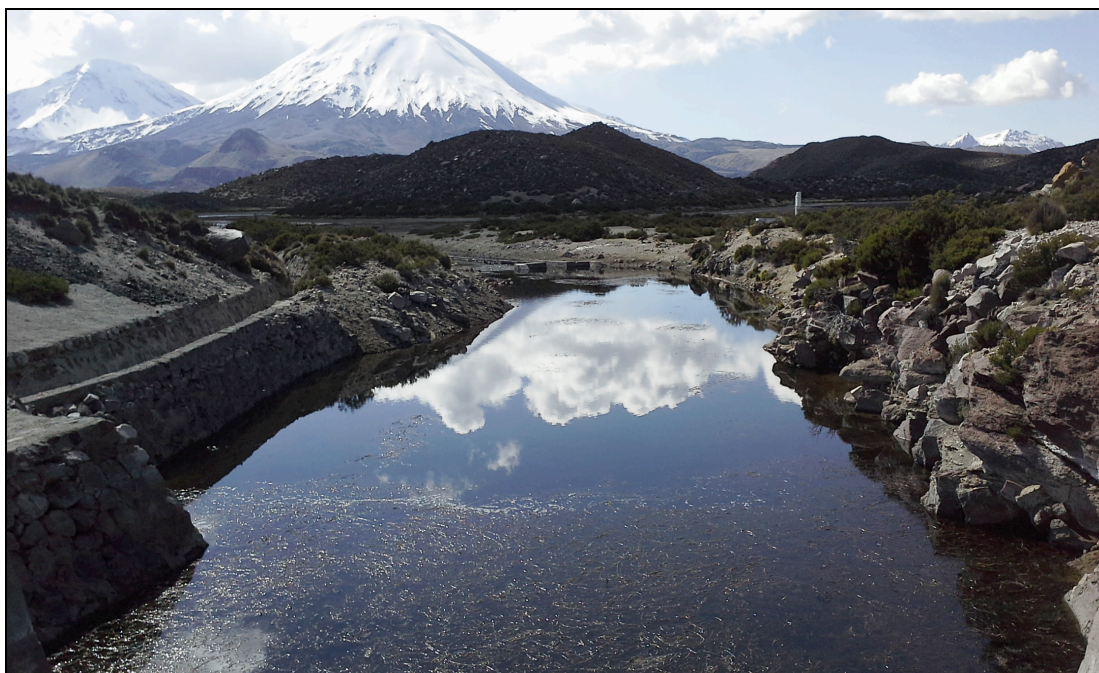
Figura 11-30. Obras de entrega "B" situadas a 115 metros de las obras de entrega "A". Fuente: DGA Arica.
