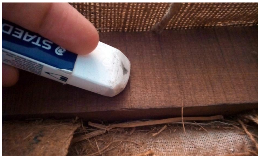
Ilustración 75: Limpieza mecánica en seco con goma de borrar.
