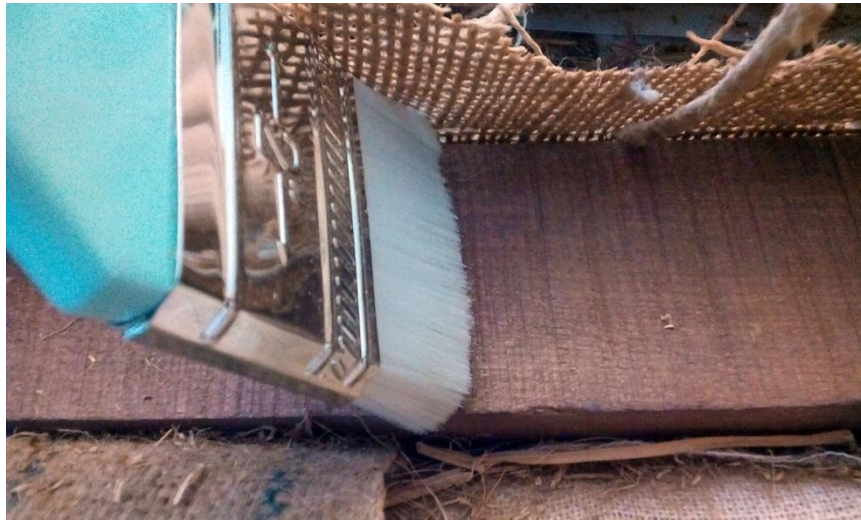
Ilustración 74: Limpieza mecánica en seco con brocha.
