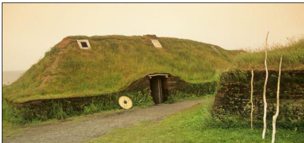
Ilustración 2. Techo vegetal de una casa vikinga.
