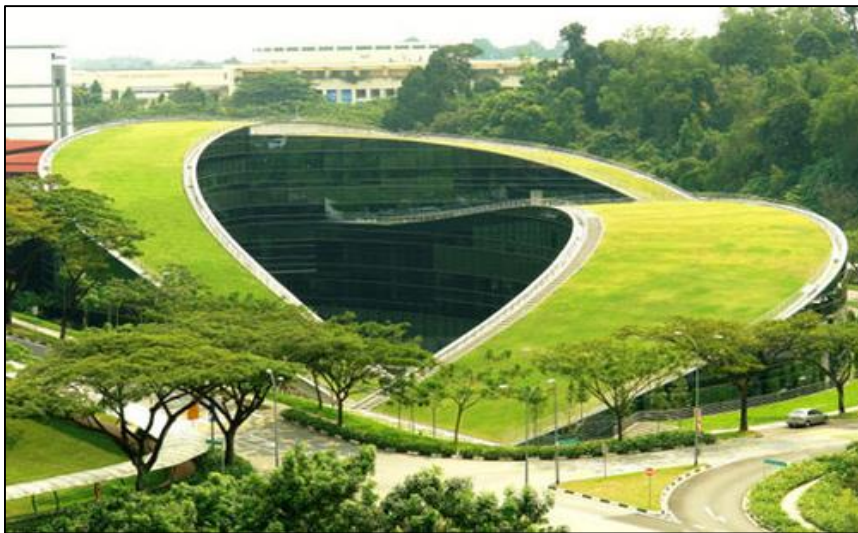
Ilustración 4. Cubierta vegetal de tipo extensiva.
