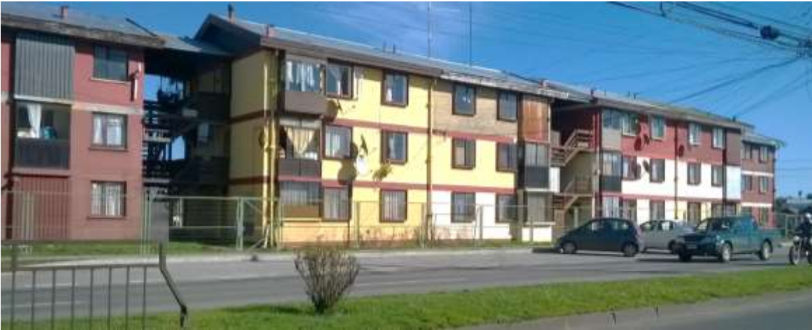
Figura 25: Aspecto típico de los Bloques Tipo C. Fuente elaboración propia.
