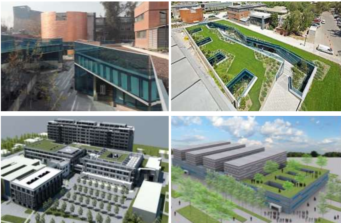
Figura 11: Arriba. Edificio Centro de Minería Andrónico Luksic en el Campus San Joaquín, Universidad Católica de Chile año 2012. Fuente http://www.disenioarquitectura.cl/centro-de-mineria-luksic-enrique-browne-puc/ Abajo. Proyectos de los nuevos hospitales de Talca y Curicó que incorporan cubiertas vegetales. Fuente http://www.diariolaprensa.cl/wp-content/uploads/2012/04/hospital.jpg
