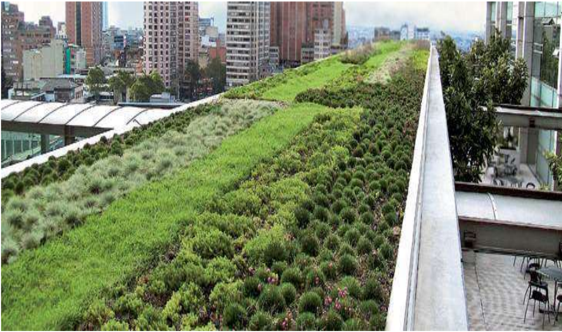
Figura 18: Imagen de una cubierta vegetal extensiva. Fuente https://ecosectores.com/DetalleArticulo/la-demanda-de-cubiertas-vegetales-en-espacios-urbanos.aspx
