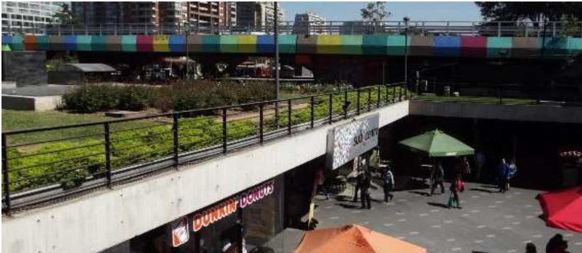
Figura 12: Sub Centro estación de Metro Escuela Militar en Las Condes. Fuente: Elaboración propia, 2015
