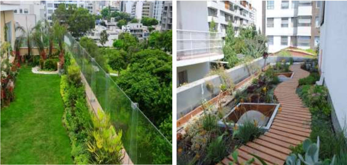
Figura 20: Imagen de una cubierta vegetal intensiva, muestra una alta complejidad tanto en el diseño como en los sistemas de mantención y altura de especies. . Fuente http://www.fibrit.com/productos-prefabricados/terrazas/cubiertas-verdes/
