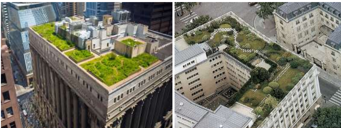
Figura 22: Intervenciones de la cubierta en edificios antiguos que proponen espacios de áreas verdes debido a la escasez de suelo en zonas céntricas de la ciudad. Fuente http://fomentoterritorialblog.com/tag/fomento-territorial/2014
