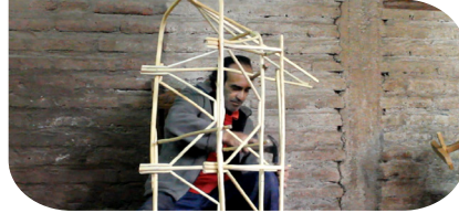
Imagen X Construcción refuerzos respaldo, Elaboración propia.
