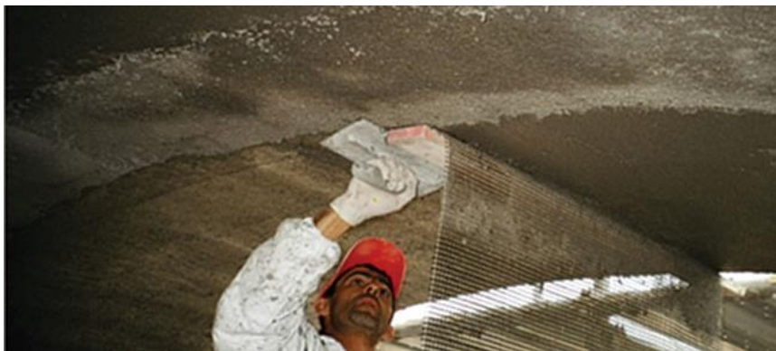
Figura 3.1. Aplicación de la Malla de Fibra sobre la Matriz Cementícea.
