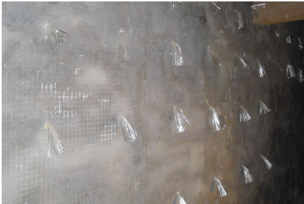
Figura 3.4. Conector de Anclaje Mallas de Fibras, G&P Intech.
