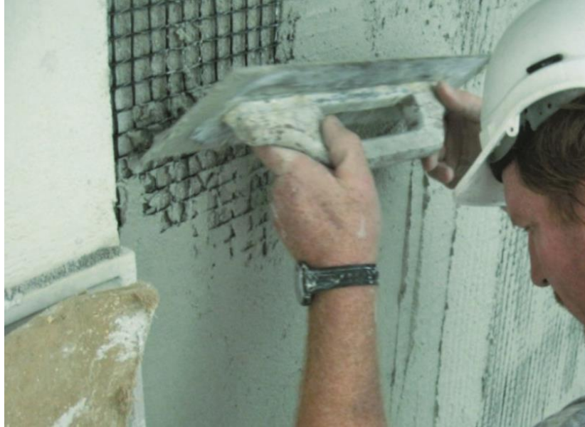
Figura 3.2. Aplicación de la Matriz Cementícea sobre la Malla de Fibra.
