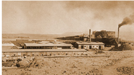
Fig. 143. Planta de elaboración de la oficina salitrera La Palma. Fuente: Álbum zona norte de Chile, Informaciones Salitreras, Juvenal Valenzuela, sin fecha.
