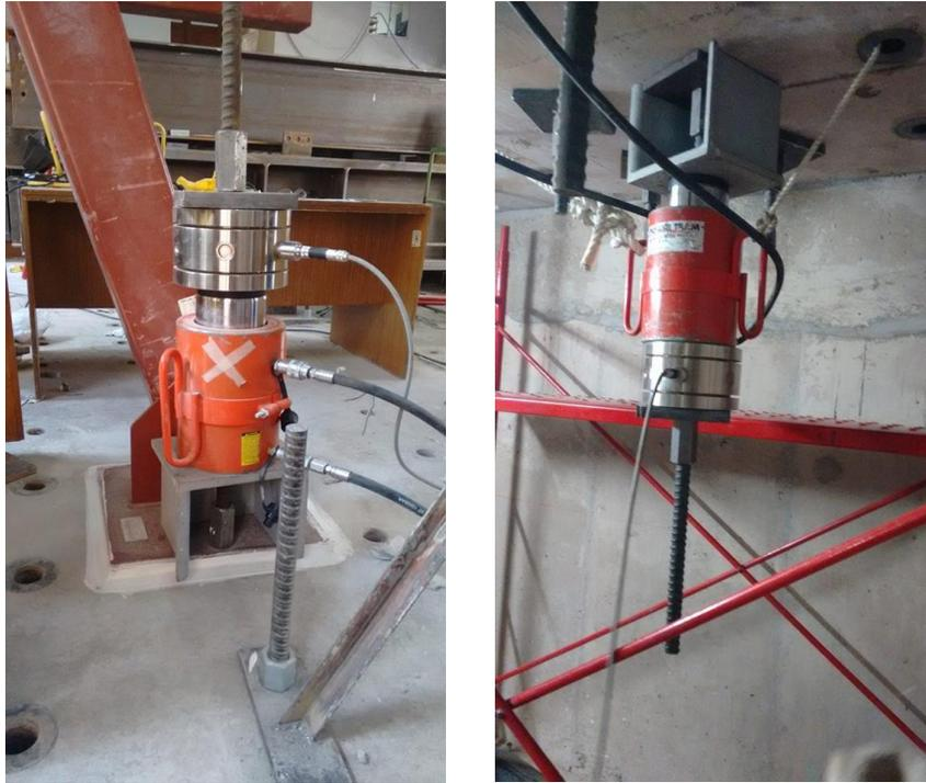
**Figura 6-9 Postensado de barras de anclaje sobre y bajo la losa**
