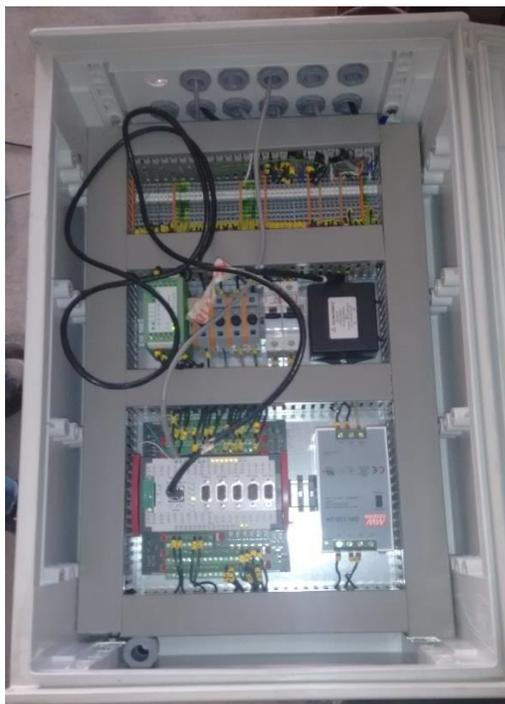
Figura 5-1 PLC actuador hidráulico
