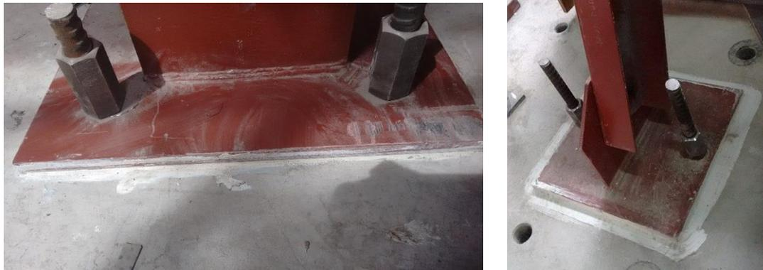
**Figura 6-8 Aplicación de Nivelante**
