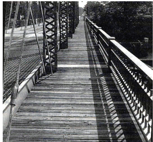
Figura 1. Monumento puente mostrando las aceras de madera.
