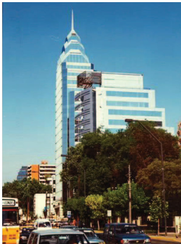
Fig. 4: Edificio corporativo Cruz Blanca. Santiago de Chile. 1992. Arquitecto: Gustavo Krefft. Fuente de la imagen: http://www.skyscrapercity.com/showthread.php?t=567876
