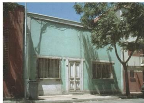
Fig.53: Casa de Luis Montt, año 1990. Fuente: Ilustre Municipalidad de Santiago (2000)
