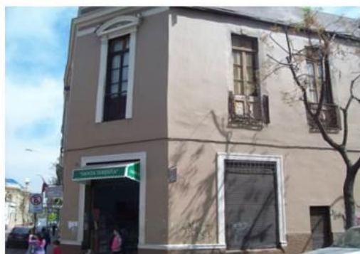
Fig.59: Fachada del almacén “Santa Teresita”, entre las calles Catedral y Herrera. Fuente: Autor, 2014.
