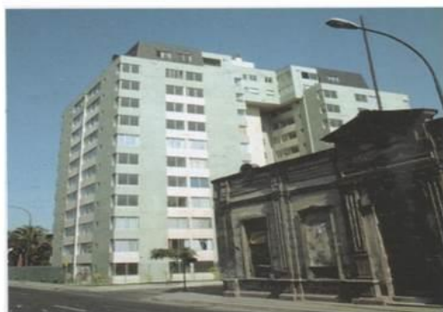
Fig.50: Departamento en altura del año 1992, ubicado en calle Maipú. Fuente: Ilustre Municipalidad de Santiago (2000)
