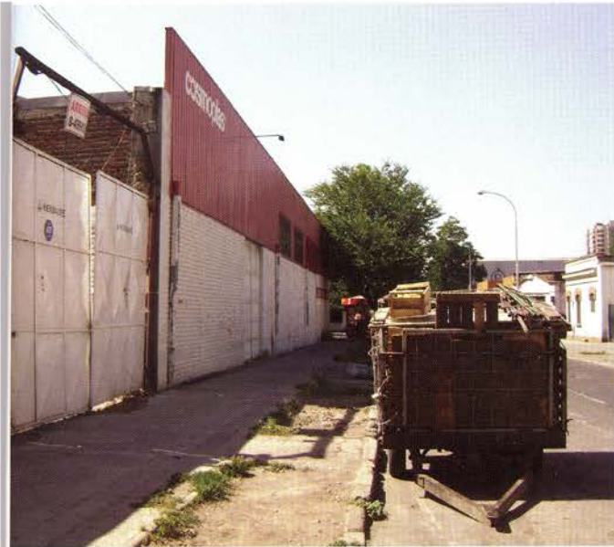
Deterioro del espacio público en las cercanías de Av. Diez de Julio Huamachuco, año 2009.
