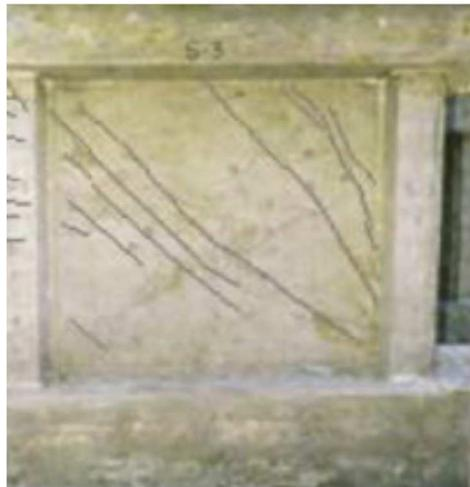
**Figura 5.2** Grietas de corte en un muro corto (Kassem, 2010).
