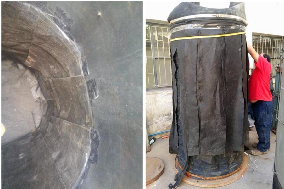
**Figura 28: colocación de geotextil**
