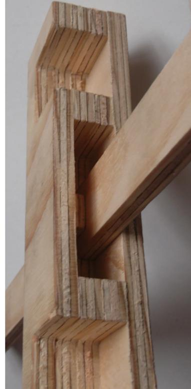
Detalle ensamblado de estructura base
