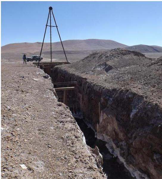
Figura 12. Canal artificial construido para conectar el salar de Pedernales con el río Salado.
