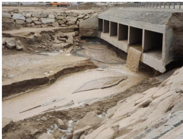
Figura 96 Canaletas del cauce del río Salado donde la carretera colapsó. Notar el tamaño de los túneles.
