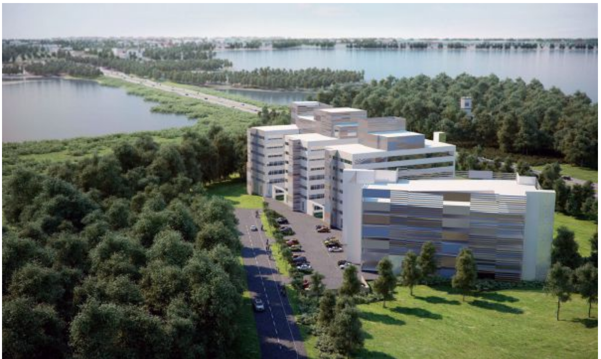
FIGURA 5.7 EDIFICIO DERBY BUSINESS PARK PERSPECTIVA FUENTE: WWW.TEKLA.COM
