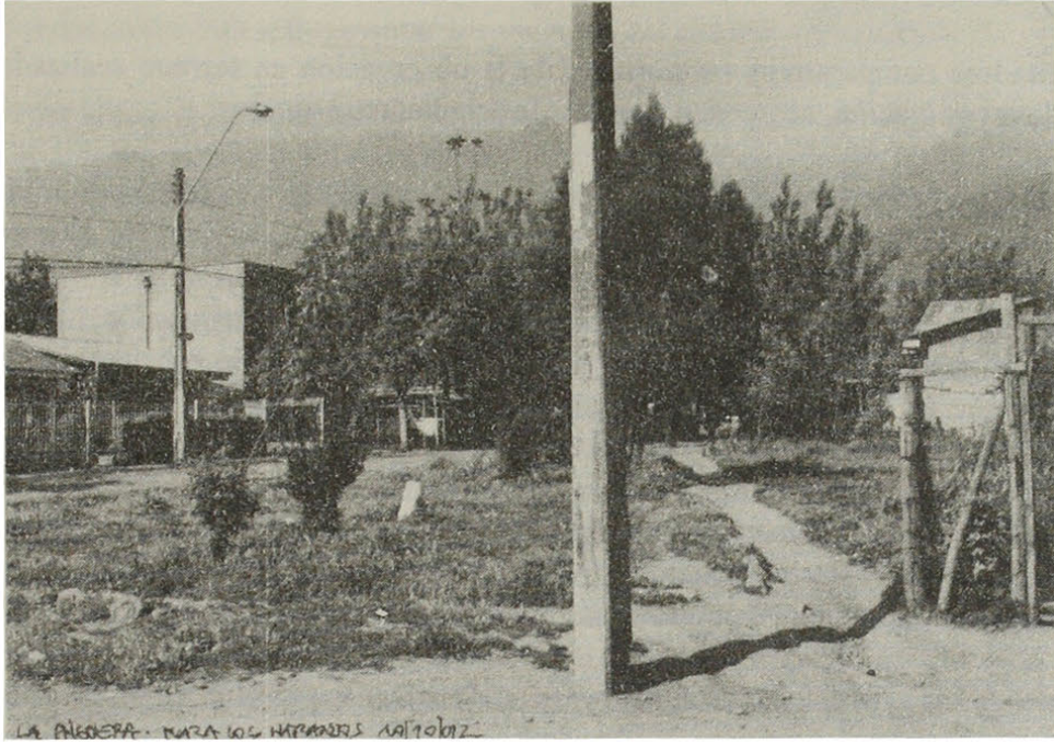
VISTA GENERAL DE LA PLAZA LOS NARANJOS.
