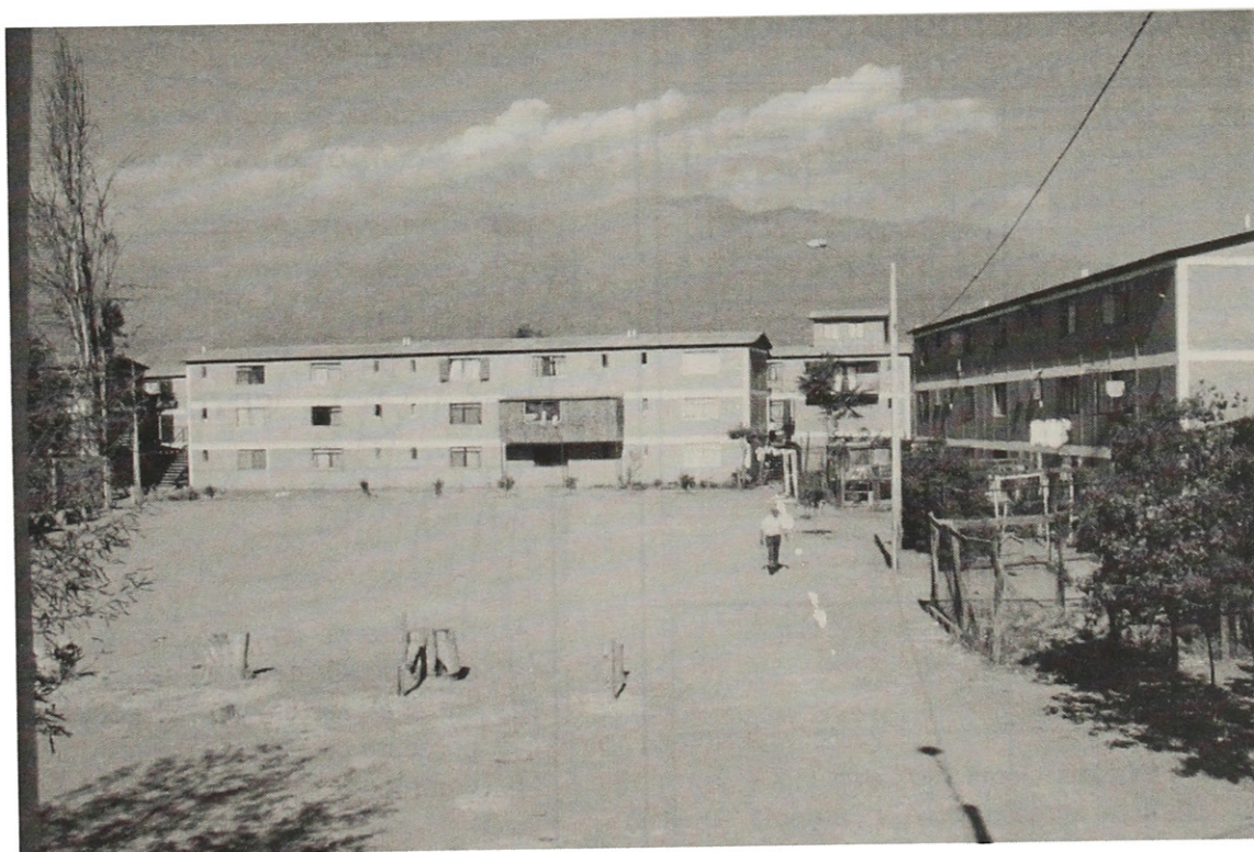
Los Quillayes, Sector 5B. La foto muestra el espacio interior que se define por el emplazamiento de los bloques y que facilita su control físico y visual por parte de los sistemas familiares y vecinales.
