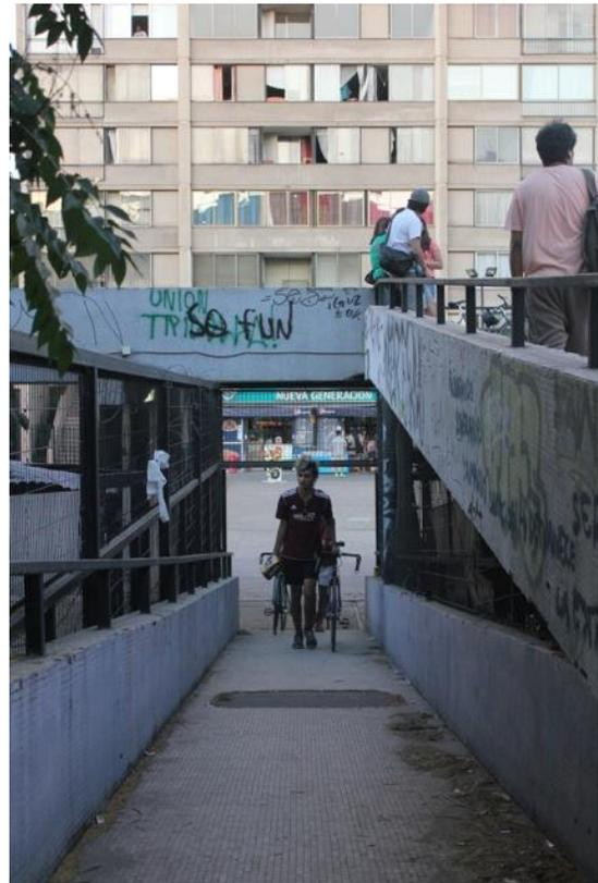
Imagen 29. La rampas de acceso permiten la circulación sobre ruedas, facilitando el acarreo de mercadería, el ingreso se ciclistas y, sobre todo, la inclusión de discapacitados y personas de la tercera edad.
