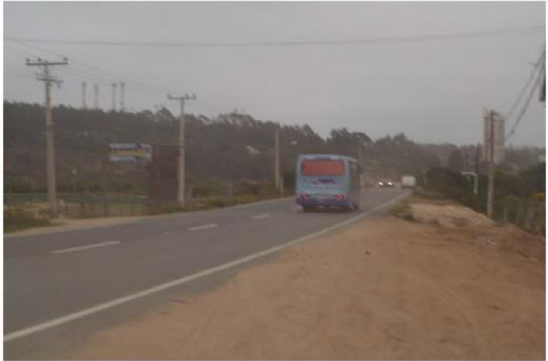
Vialidad para autos con acera peatonal sin pavimentar camino Algarrobo Mirasol
