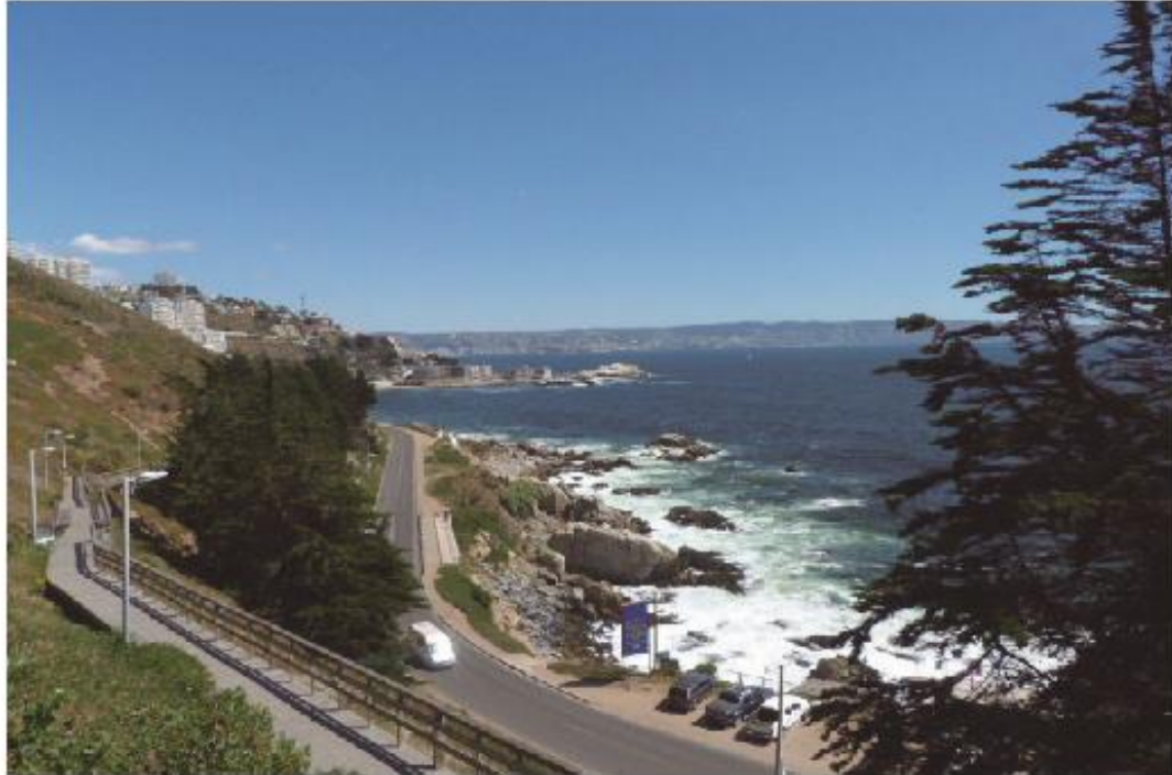
Vista de un tramo del camino escénico Concón Reñaca.
