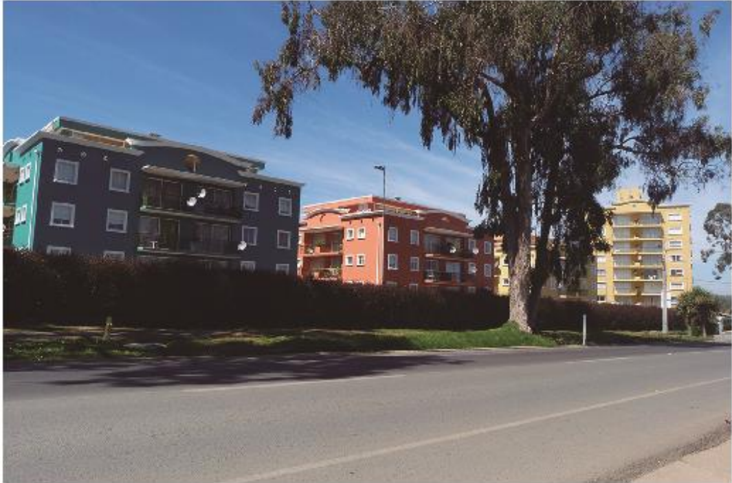
Edificación cuatro y ocho pisos emplazados en calle principal, Mirasol
