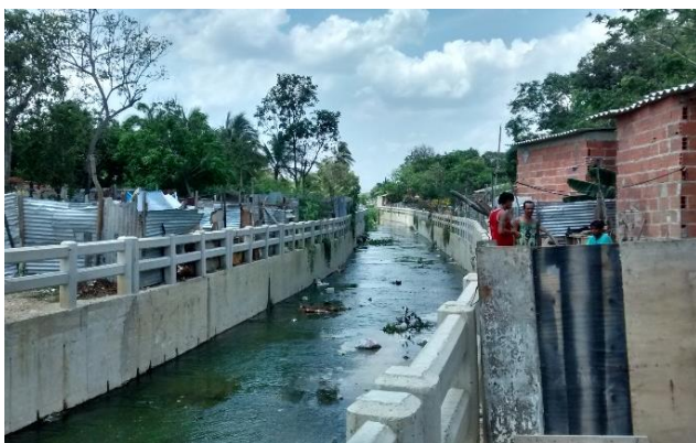
➤ Gráfica 5-7. Vista canalización del Arroyo La Esmeralda.
