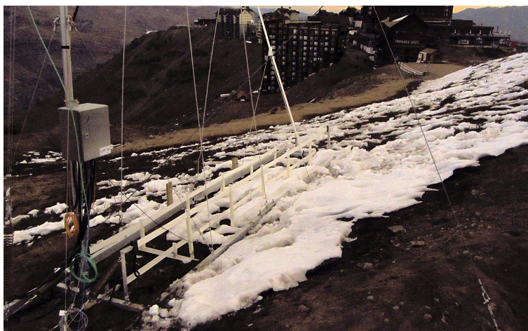
(a) Instalación SPA en estación UChile-Valle Nevado. Mayo 2013
