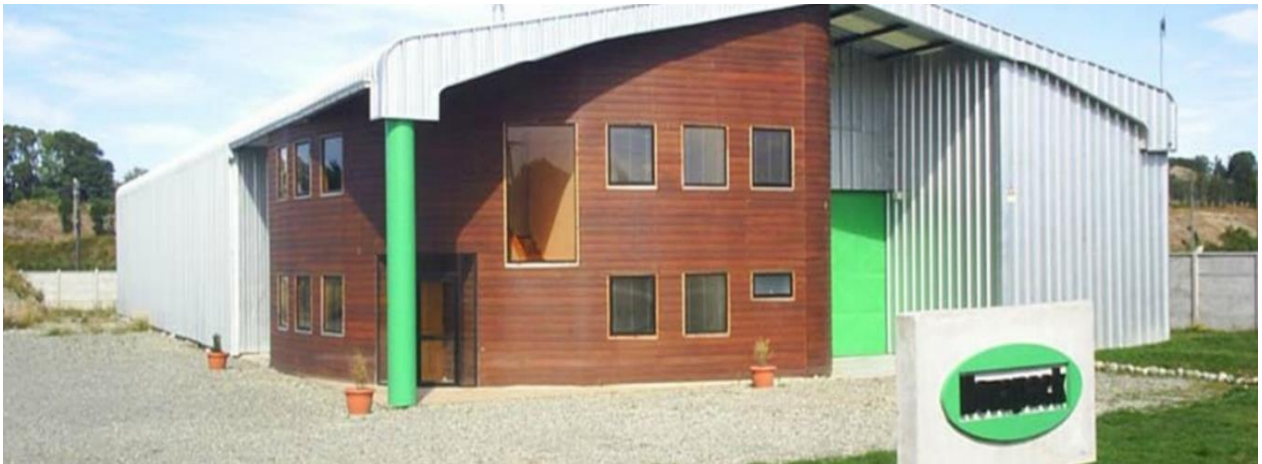
Figura 5: Oficinas y galpón principal de Novapack. Fuente: Novapack Ltda.
