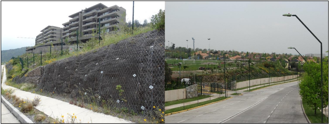
Figura 4.27. Intervención antrópica. A la izquierda se observa mallas con pernos; a la derecha, muros de hormigón y camino asfaltado.
