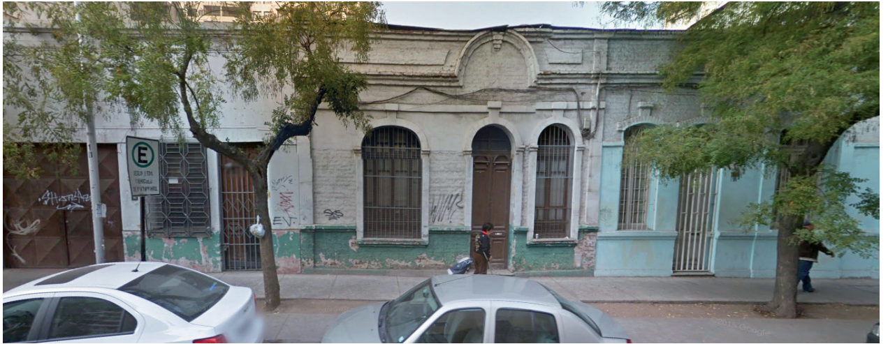
Calle Santa Victoria, vista al Norte, terrenos del paño N° 320 y N° 322
