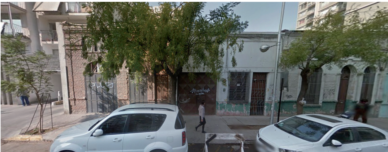
Calle Santa Victoria, vista al Norte, terrenos del paño N° 316 y N° 318
