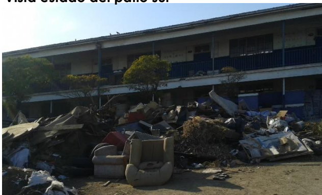
Vista estado del patio sur
