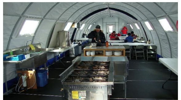
Imagen 20: Envoltentes opacas para disminuir iluminación interna. (Fuente: Coronel Rafael Castillo)
