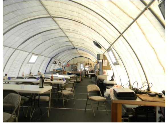
Imagen 19: Envoltentes traslúcidas para aumentar iluminación interna. (Fuente: Coronel Rafael Castillo)
