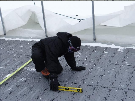
Imagen 87: Sistema de placas de piso técnico modular autotrabados. (Fuente: Coronel Rafael Castillo)
