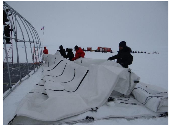
Imagen 75: Manto de tela técnica aislante e impermeable desarrollada por domos.com (Fuente: Coronel Rafael Castillo)
