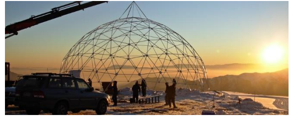
Imagen 74: Estructura de entramado de domo geodésico. (Fuente: domos.com)
