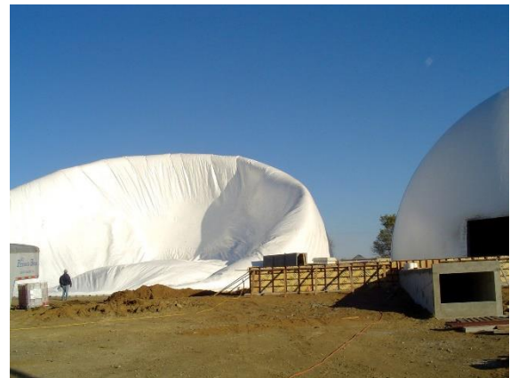
Imagen 82: Proceso de inflado de estructura neumática. (Fuente: blog.360gradosenconcreto.com )
