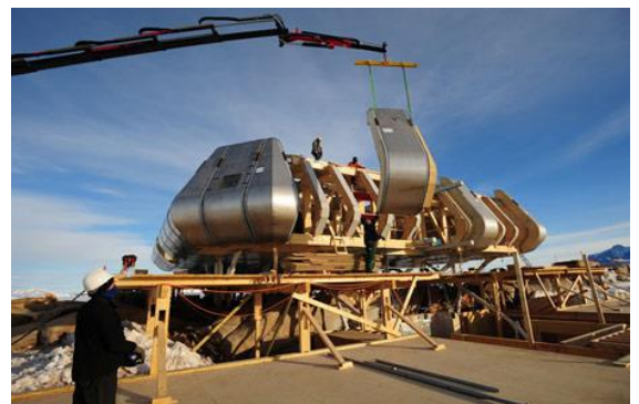
Imagen 66: Proceso de montaje y armado de la base Princesa Isabel. (Fuente: antarcticstation.org)
