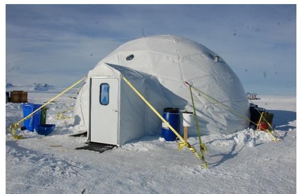
Imagen 76: Anclajes de vientos a hielo de las estructuras. (Fuente: Coronel Rafael Castillo)
