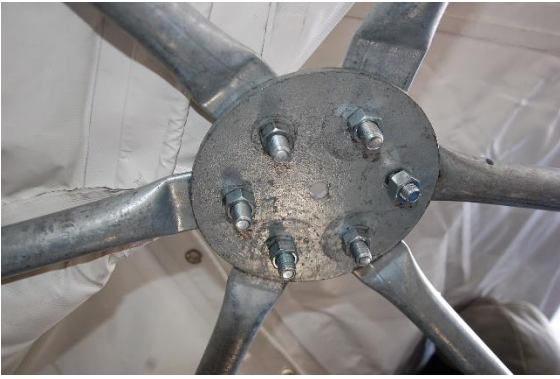
Imagen 78: Perforación en nudos para pasada de amarres de anclajes a hielo. (Fuente: Coronel Rafael Castillo)
