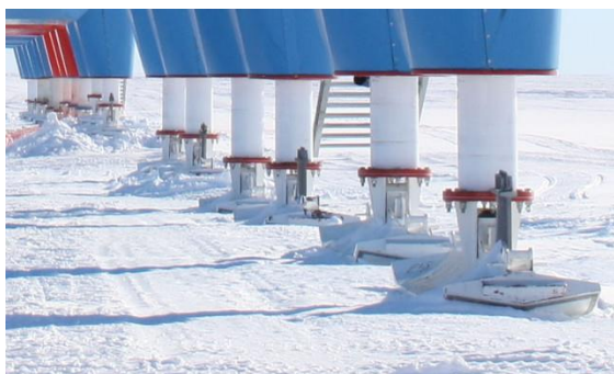
Imagen 65: Pilotes neumáticos con esquíes de los módulos de la Halley. (Fuente: bas.ac.uk)
