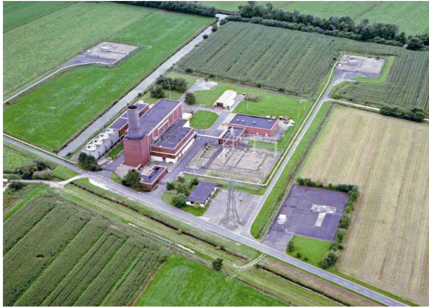
Figura 7: Fotografía aérea planta Huntorf. Tomada de KBB©.
