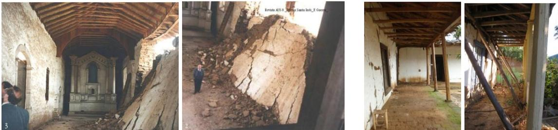
Figura 2- Muros colapsados y muros con desplomes.
