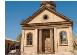
Casa e iglesia de la ex hacienda Nantoco
