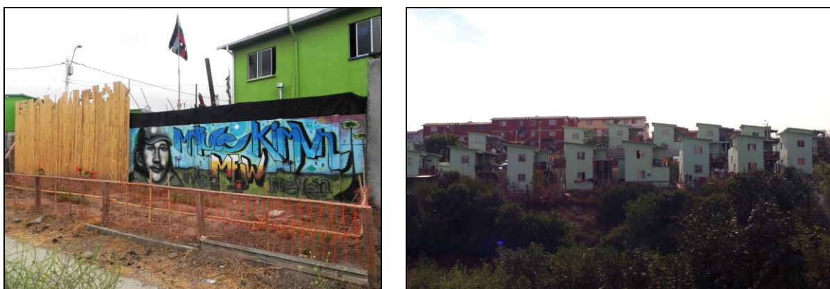
Figura 4: Villa Bicentenario, Comuna de Cerro Navia, Conjunto de vivienda de población Mapuche (izquierda); Conjunto Newen Ruka, Comuna de Viña del Mar. Conjunto de vivienda de población Mapuche-Huilliche y otras etnias (derecha)
