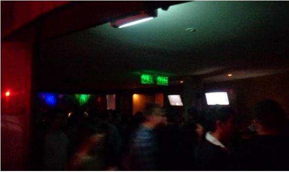
Ilustración D.2.13.: Vista general, desde ingreso de escalera acceso, de pasillo que comunica a ambas pistas centrales – señales direccionales perpendiculares al flujo del tipo foto luminiscente ubicadas en el techo (cota +3,50 m).
