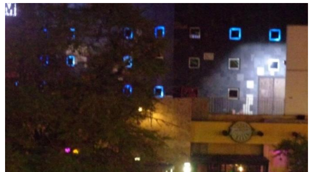
Ilustración D.1.4.: Vista lateral de entrada principal.
