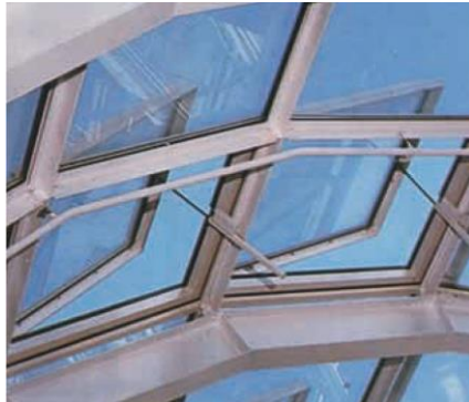
Ilustración 5.3.1.: “Claraboyas mecánicas ubicadas en el techo de los recintos.” [23]
