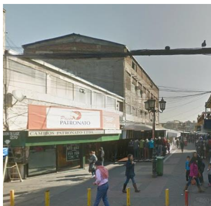
Ilustración 4.4.4.: “Vista general de la discoteca 2, fachada principal.”
