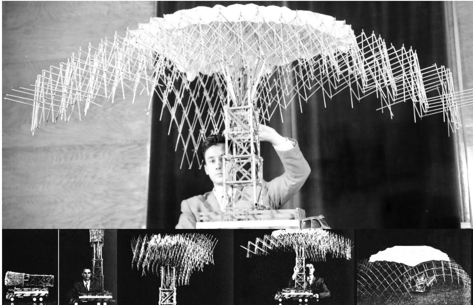
Fig.8-Emilio Perez Piñero, demostrando el transporte y despliegue de sus sistema estructural.( Fuente: www.vedoque.com . Año 1961)
