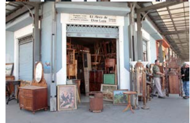
(arriba a abajo) Imagen 38: entrada de galería en Av. Italia, muestra fachada intervenida con ladrillo a la vista. Imagen 39: esquina del barrio, ejemplo de líneas rectas y simetría en arquitectura. Imagen 40: entrada de galería en Av. Italia, bimataterialidad fachada, en madera a la vista y cemento. Muestra complemento entre luminarias y áreas verdes del barrio. Imagen 41: esquina de restauradores en Estación Caupolicán, destaca por su arquitectura y profundidad en la composición de su estructura.
