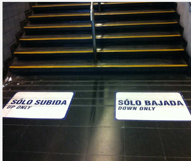
Figura 7: Escaleras Estación de Metro Las Rejas
