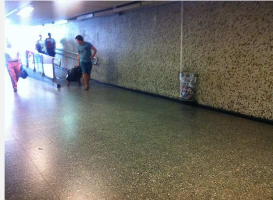
Figura 53: Basurero en pasillo Estación de Metro Salvador.
