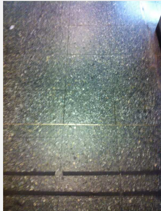
Figura 36: Pavimento pasillos y andenes de la Estación de Metro Salvador.
