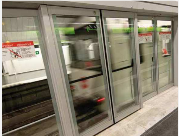
Figura 78: Sistema de puertas de seguridad en el andén del Metro de Barcelona, España.
