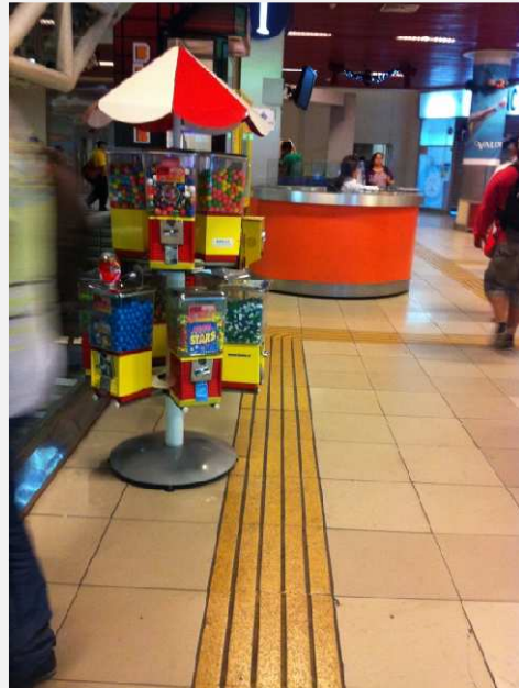
Figura 31: Pavimento Táctil- Estación de Metro La Cisterna.
