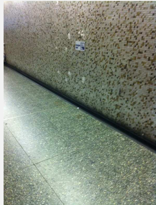
Figura 39: Muros pasillos y andenes de la Estación de Metro Salvador.
