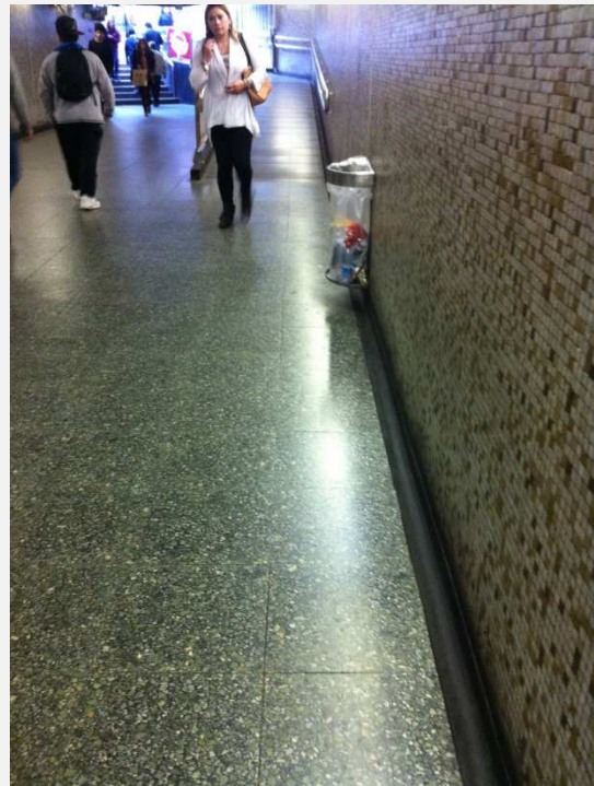
Figura 54: Basurero en pasillo Estación de Metro Salvador.
