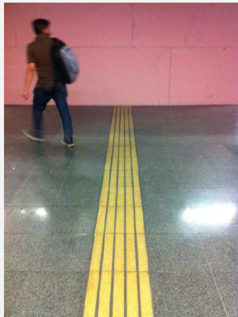
Figura 32: Pavimento Táctil- Estación de Metro La Cisterna.
