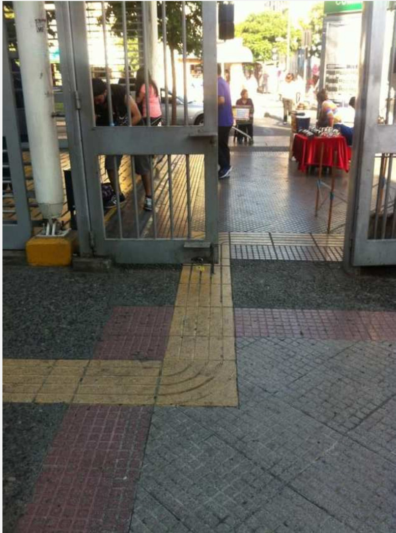
Figura 33: Pavimento Táctil - Exterior Estación de Metro Cummings.
