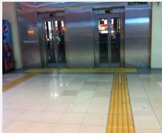
Figura 83: Pavimentos guías en ascensores de la estación de Metro La Cisterna.
