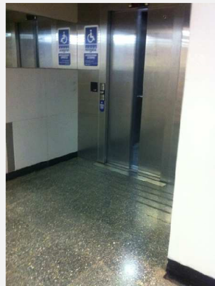
Figura 47: Ascensor- interior de la Estación de Metro Salvador.
