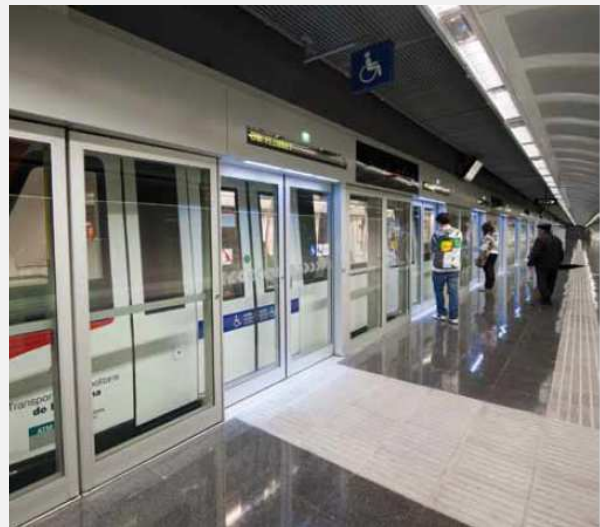
Figura 79: Pavimento táctil frente a las puertas de seguridad en el andén del Metro de Barcelona, España.
