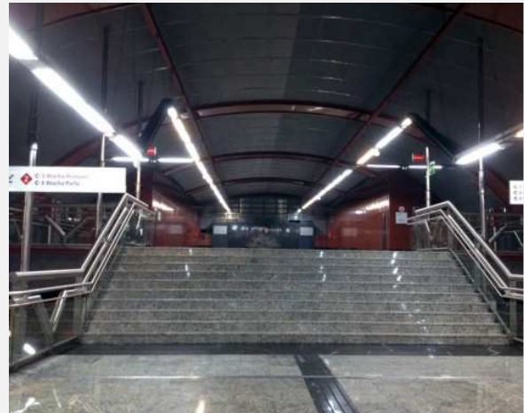
Figura 81: Pavimento táctil frente a las escaleras del Metro de Madrid, España.
