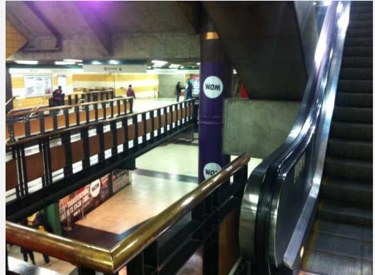
Figura 57: Pasillos y escaleras de la Estación de Metro Baquedano.
