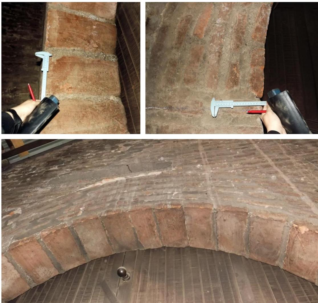
Imagen 111 - Detalles del levantamiento de arco descrito. Fuente: Elaboración propia.
