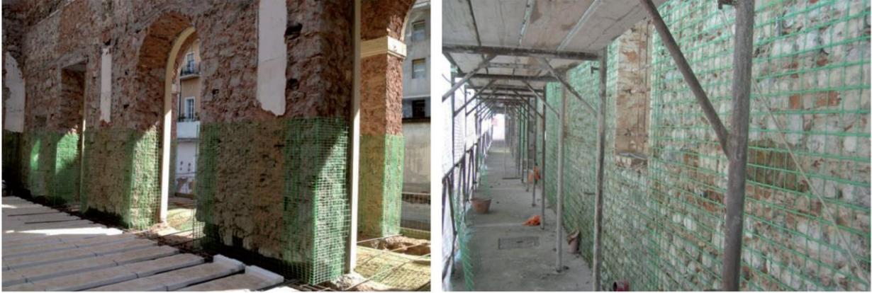
144 - Ejemplo de ejecución de mallas de refuerzo en muros. Fuente: Sistema Fibrebuild FRCM.
