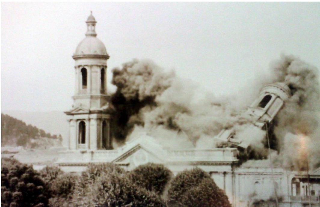
*Imagen 119 -Demolición de las torres de la Catedral de Concepción, en 1939. Se indica en la bibliografía que las torres, construidas como intervención posterior en 1904, provocaron daños en el resto del edificio por lo que se decide dinamitar, cuya consecuencia es la demolición total del resto del templo. Fuente imagen: Libro "Concepción Desaparecido", Cartes Montory y Alejandro Mihovilovich*
