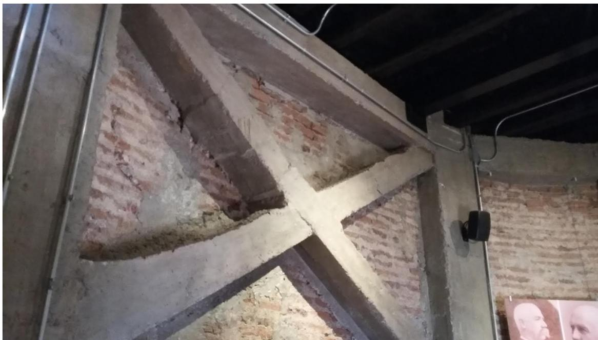
*Imagen 141 – Ejemplo de refuerzo interior de hormigón en albañilería. Caso torre de Museo Histórico Nacional. Fuente: autores.*
