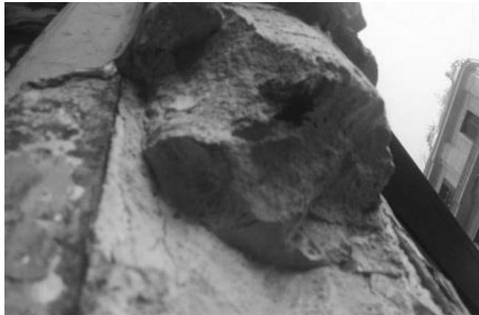
Imagen 83 - Relleno de cemento y estribos en pilares de Comercial Edwards. Fuente: C. Valenzuela, 2014.
