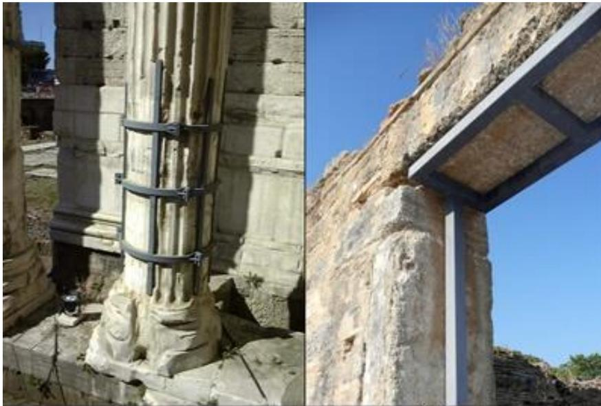
Imagen 142 -Ejemplos de refuerzos metálicos en estructuras clásicas.
