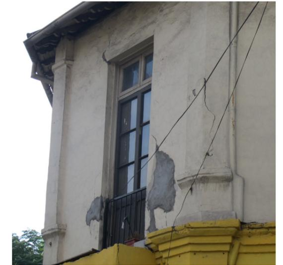
Fig. 3.16. Desprendimiento de pintura, reparaciones e instalaciones a la vista. Fuente: Fot. autores (2014).
