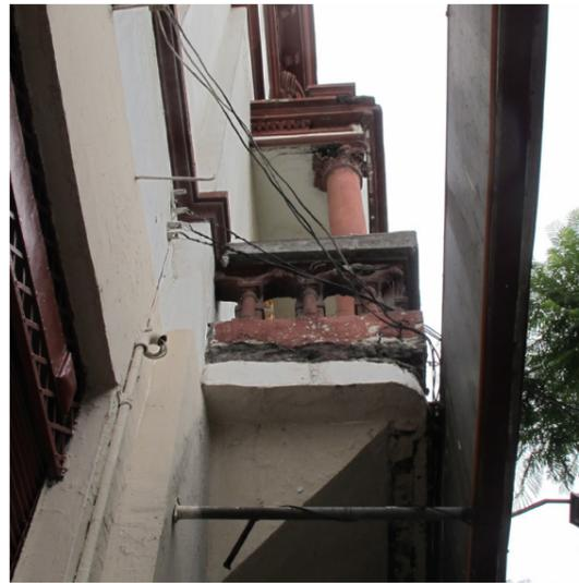
Fig. 3.84. Detalle de baranda y desprendimiento de material. Fuente: Fot. autores (2014).
