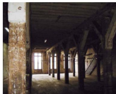
Se conserva la estructura de madera original del edificio, de formato planta libre para almacenaje y bodega.
