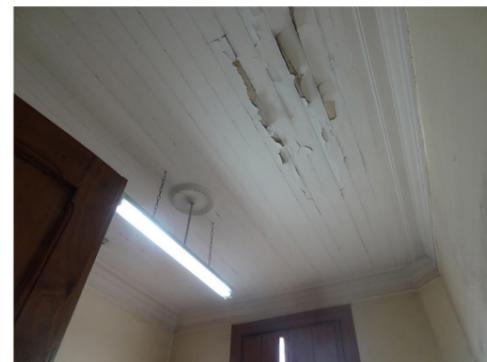
9. Desprendimiento de pintura en cielos segundo piso. Posible escurrimiento de cubierta.
