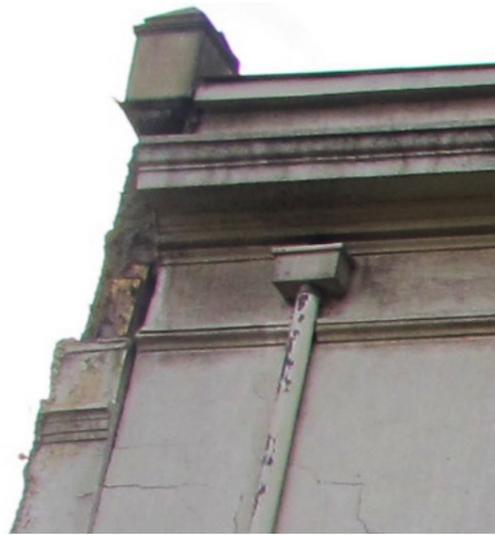
Fig. 3.8. Desprendimiento de estucos en muro medianero. Fuente: Fot. autores (2014).
