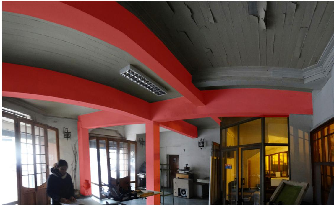
Fig. 6.8. En rojo se muestran los refuerzos de hormigón armado en primer piso que soportan la estructura original del segundo. Fuente: Fotos de autores (2014).
