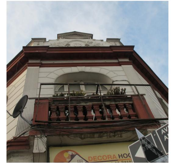
Fig. 3.73. Soporte publicitario en mal estado. Instalaciones eléctricas sobre fachada. Fuente: Fot. autores (2014).
