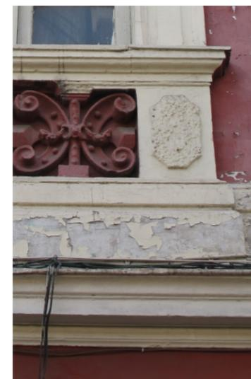
Fig. 3.63. Desprendimiento de pintura. Fuente: Fot. autores (2014).
