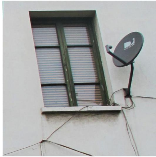
Fig. 3.10. Instalación de antena con cableado a la vista. Fuente: Fot. autores (2014).
