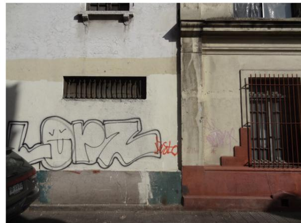
Fig. 3.54. Graffiti en muros y modificación de vanos en fachada de pasaje Lima. Fuente: Fot. autores (2014).
