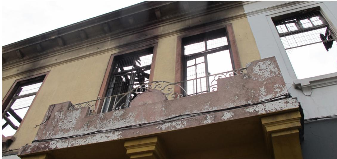
Fig. 3.52. Fachada poniente afectada por un incendio el año 2015. Fuente: Fot. autores (2016).
