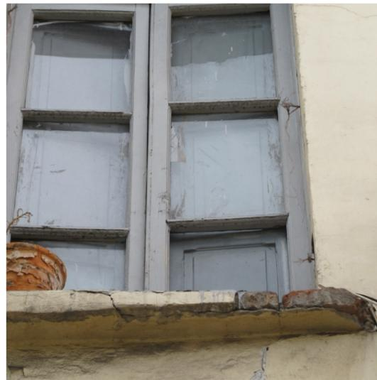
Fig. 3.20. Desprendimiento de estucos y material en antepechos. Fuente: Fot. autores (2014).
