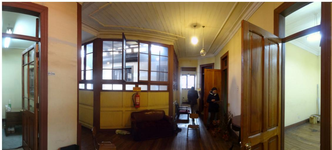
Fig. 6.9. Espacio de distribución en Matta 495. Se puede identificar la estructura de madera que configura el patio de luz y los tabiques de quincha estucados y pintados. Fuente: Fotos de autores (2014).
