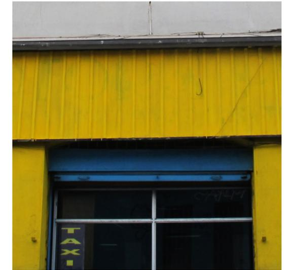
Fig. 3.6. Instalación de plancha de zinc sobre división horizontal entre pisos. Fuente: Fot. autores (2014).
