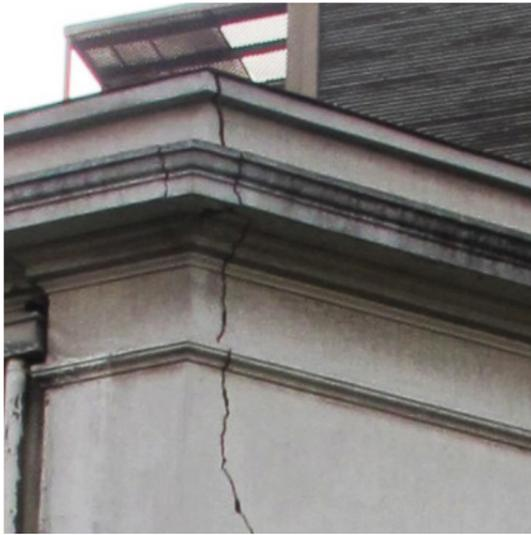
Fig. 3.7. Fisura en esquina de vano ventana de 5mm app. Fuente: Fot. autores (2014).
