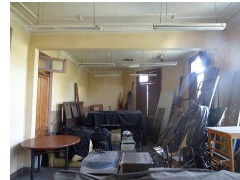
6. Salón en segundo piso ocupado para acopio. Sobrecargas constante en la estructura de apoyo.
