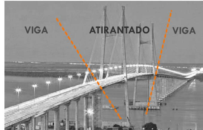
Rango de luces según el tipo de estructura.
