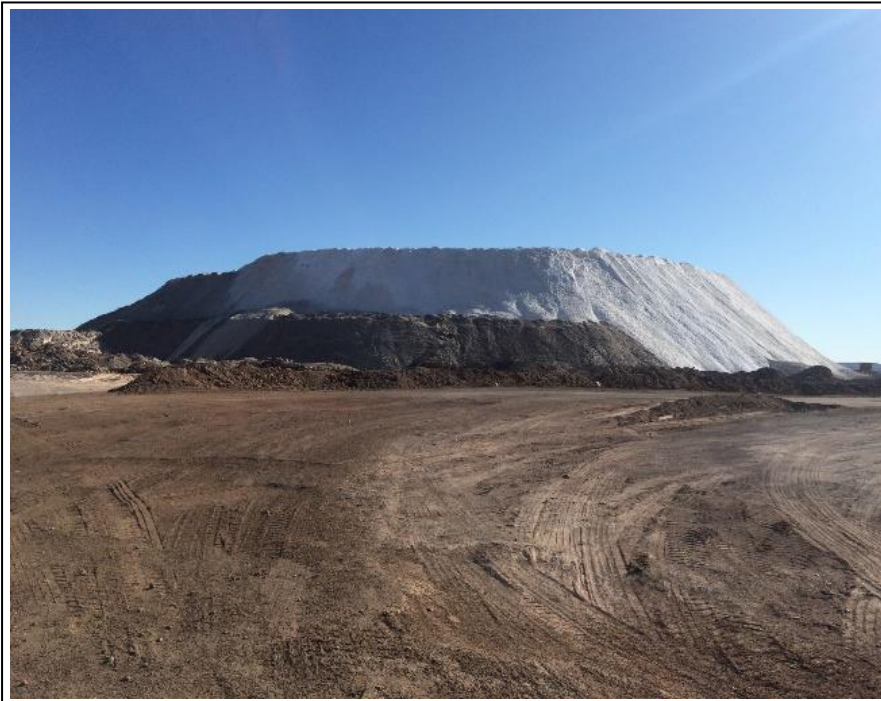
Imagen N°5: Proceso de pila de lixiviación. Fotografía de la autora (julio 2015)
