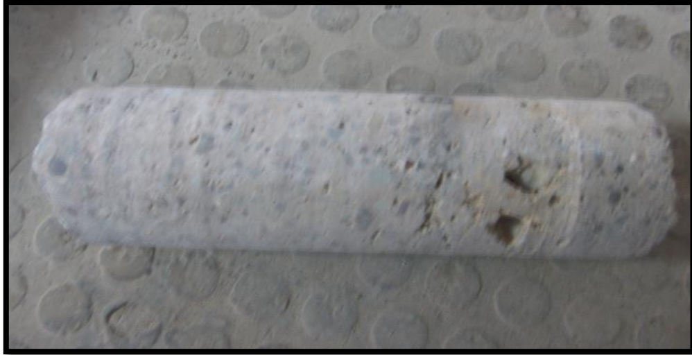
Imagen 3.5: Testigo con oquedad.
