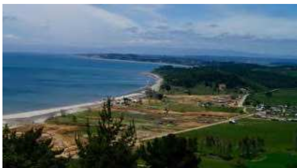
Fotografía N°1: Vista de Llico con los efectos post 27F, enero 2011. Archivo Observatorio de la Reconstrucción Universidad de Chile
