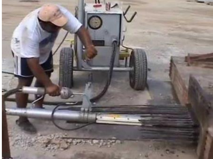
Figura 17: Ejecución de postensado de anclajes. Gentileza: https://www.youtube.com/watch?v=kfJTsYpTtm4
