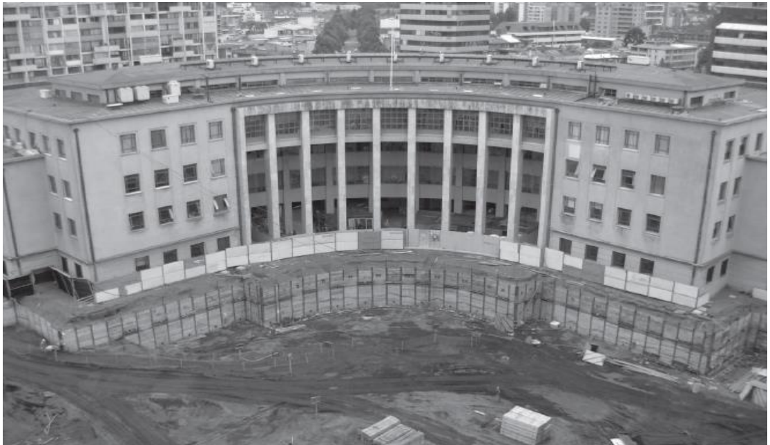
Figura 48: Muro Berlinés construcción subterráneo. Villalobos y Oróstegui (2010).
