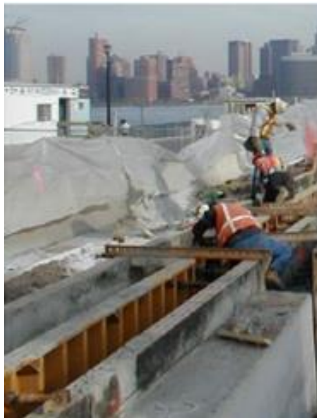
Figura 44: Construcción brocal, Richards (2006).
