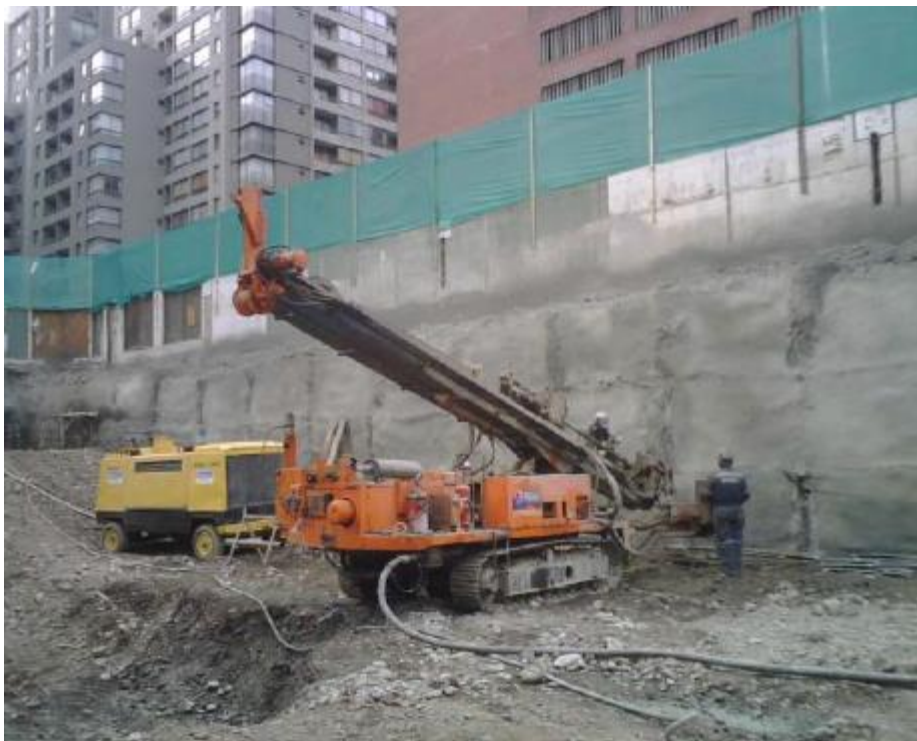
Figura 52: Soil Nailing en entibación subterráneos Edificio Catedral III, Santiago. Pilotest Terratest (2011).
