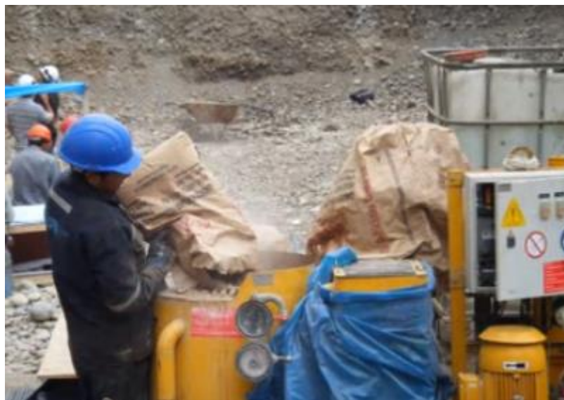
Figura 54: Mini planta de lechada de cemento. Gentileza: https://www.youtube.com/watch?v=cyAJlr5MrAs
