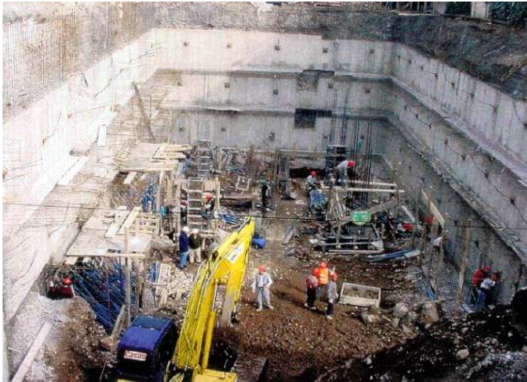
Figura 55: Muro Colgado en entibación de edificio Universidad Finis Terrae. Pilotest Terratest (2005).
