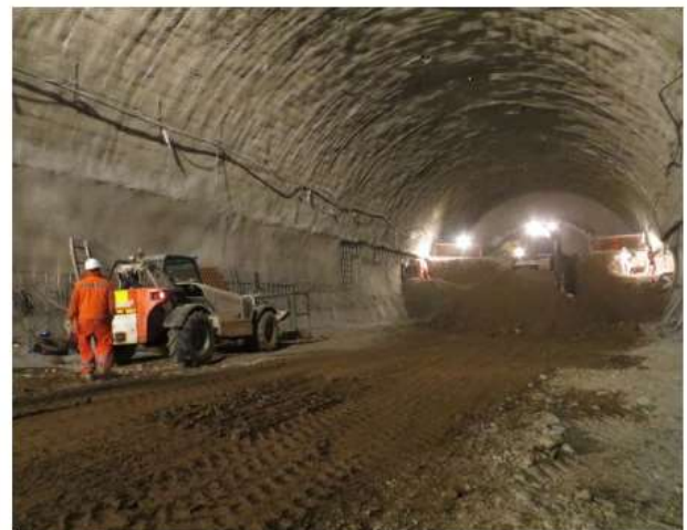
Excavación de los Bancos Túnel Estación
