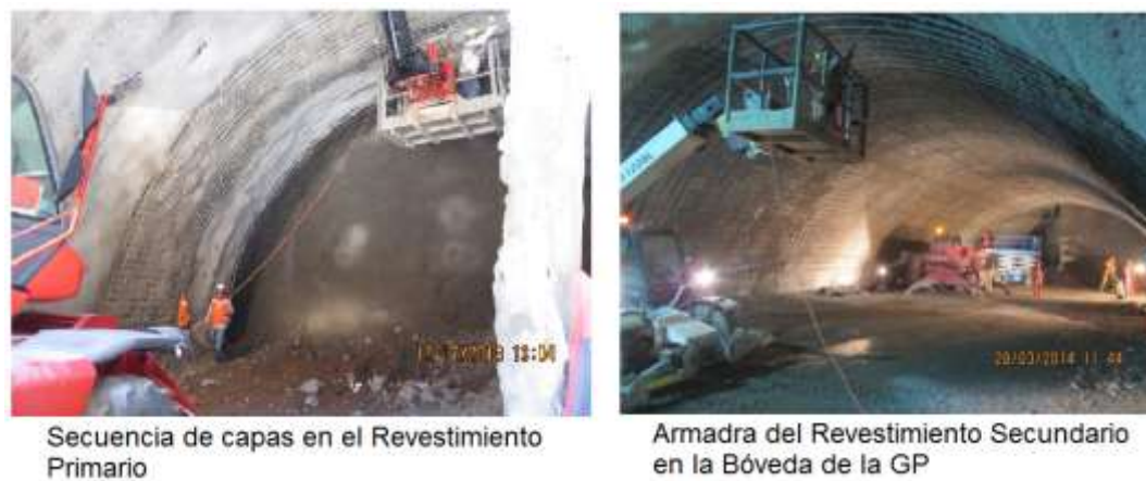
Figura 76: Revestimiento Primario (izquierda) y Secundario (derecha) de la GP (Velazco, Eduardo).
