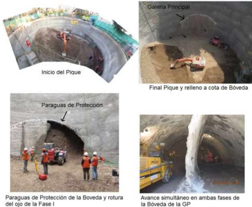
Figura 75: Construcción del Pique e Inicio de la Bóveda de la Galería Principal. (Velazco, Eduardo).
