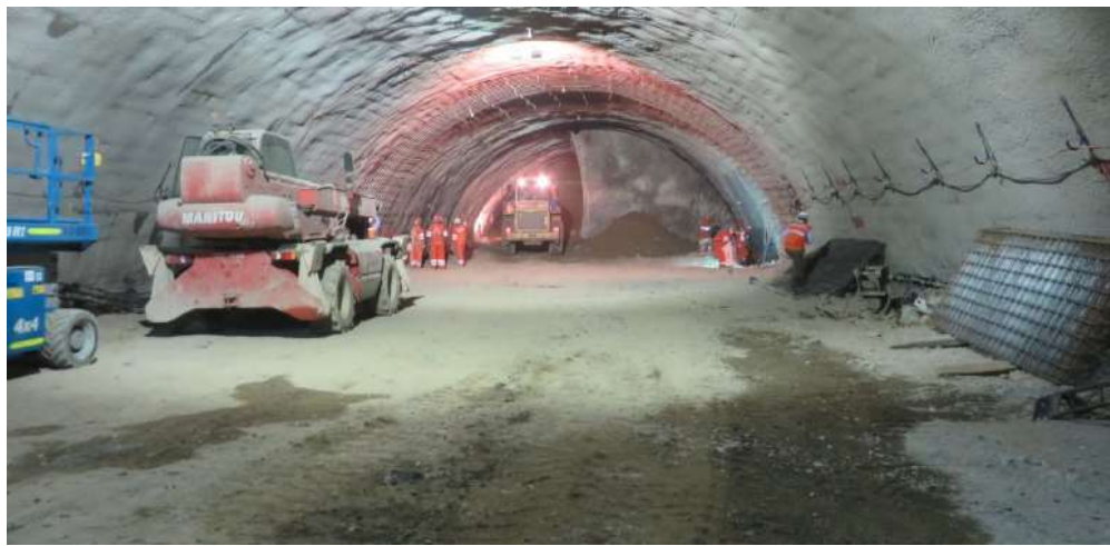
Figura 78: Avance en Fases del Túnel Estación (Velazco, Eduardo).
