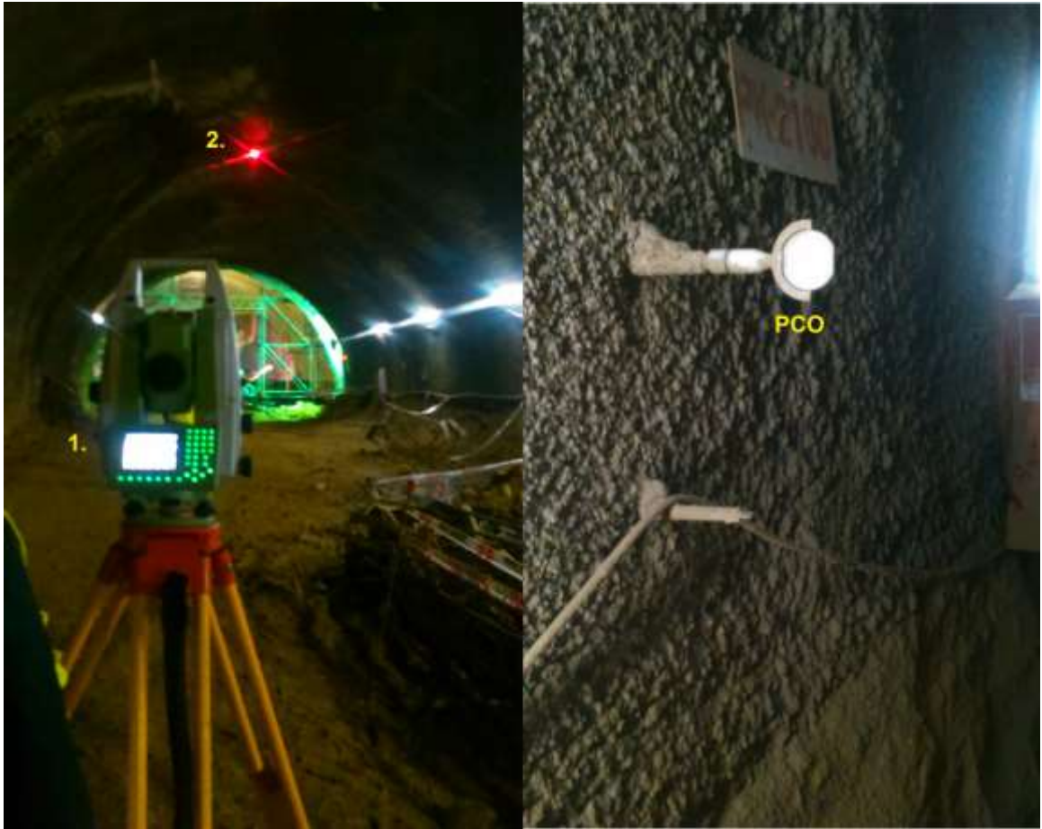
Figura 82: Monitoreo subterráneo tridimensional de desplazamientos absolutos, para la mediciones de Convergencias, (1) Estación Total Leica TM30 y (2) Punto de Control Óptico PCO (elaboración propia).
