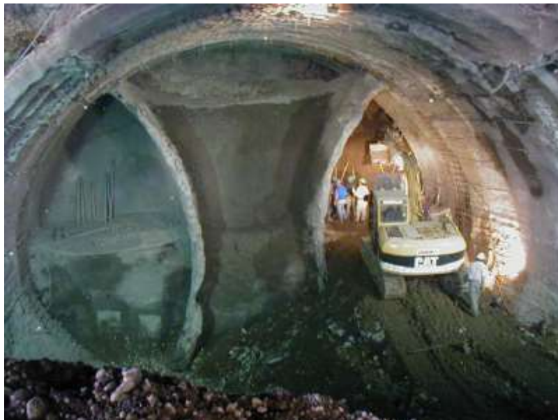
Figura 2: Excavación Manual Secuencial en Suelos Granulares, Metro de Santiago Línea 5 (Gomes, A. (A) 2014).
