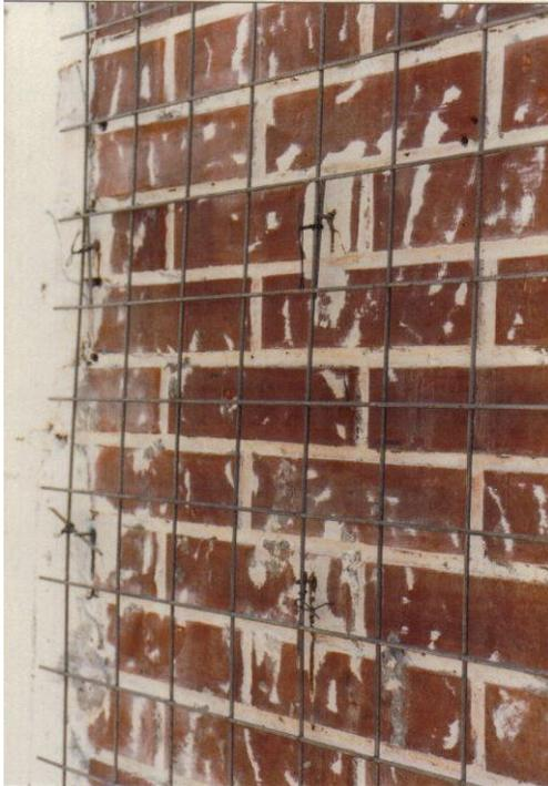
**FIG. 3.10.B Detalle Colocación Malla**
