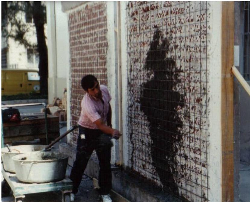
**FOTO 4.5 Colocación de Estuco con Malla de Refuerzo**
