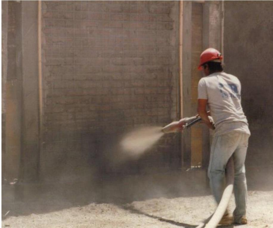
**FOTO 4.9 Colocación de Shotcrete con Malla de Refuerzo**
