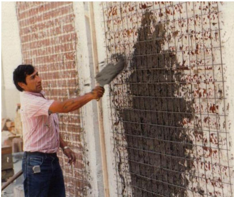
**FOTO 4.6 Colocación de Estuco con Malla de Refuerzo**
