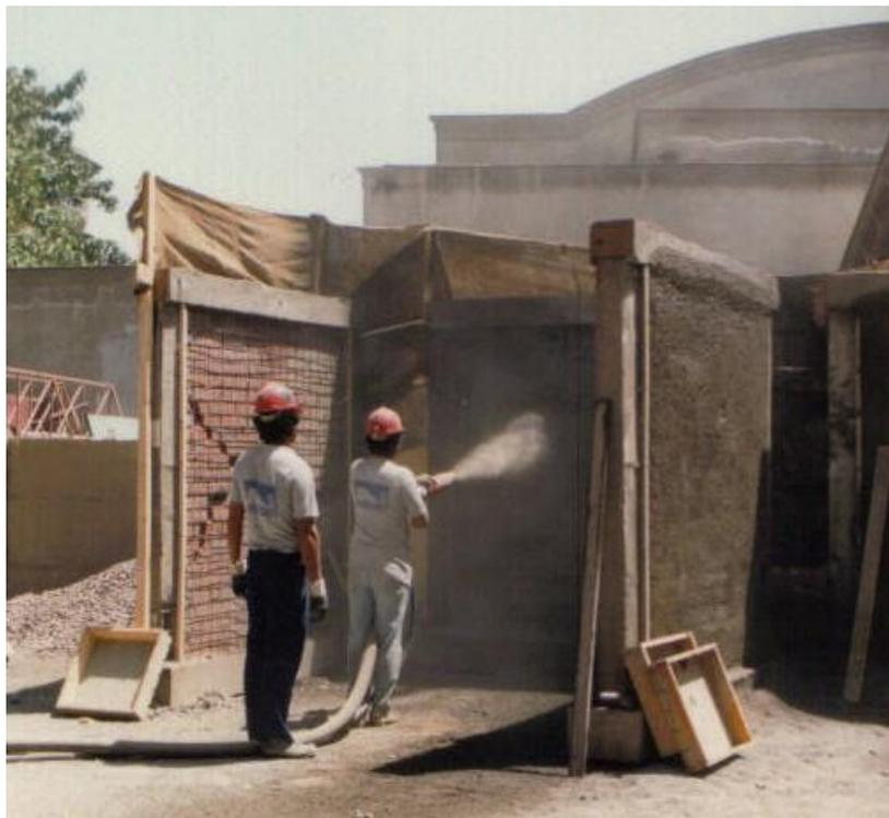
**FOTO 4.8 Colocación de Shotcrete con Malla de Refuerzo**
