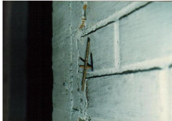
**FIG. 3.10.C Gancho Anclaje Malla**
