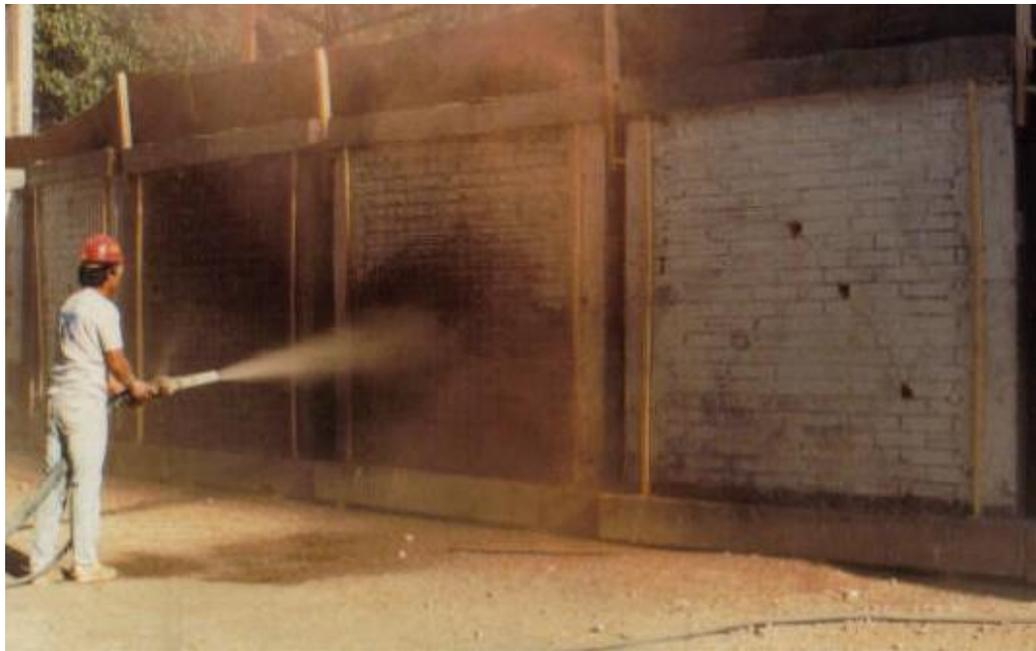
**FOTO 4.7 Colocación de Shotcrete con Malla de Refuerzo**
