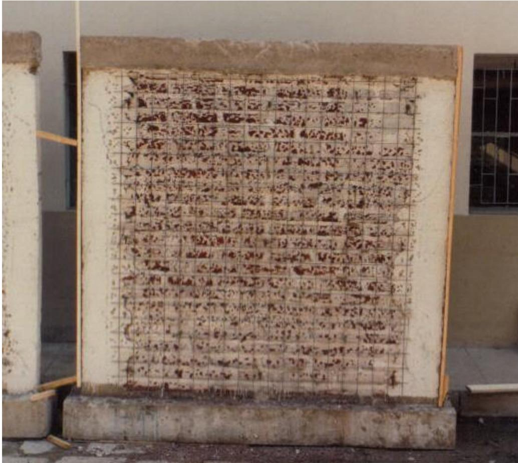
**FIGURA 3.12.A Preparación manual de superficie**
